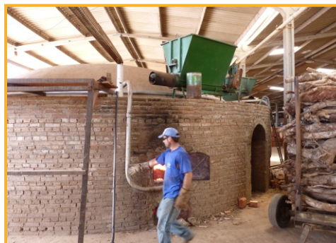
Alimentador automático de combustível
