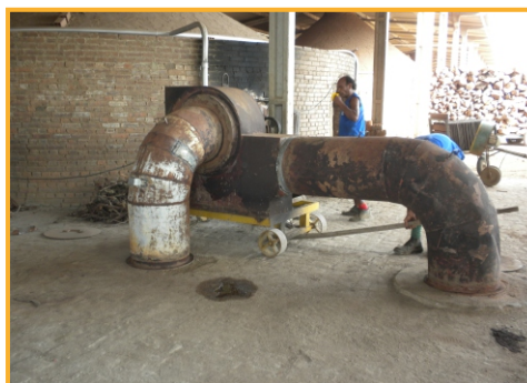
Exemplo de dutos para pré-aquecimento
