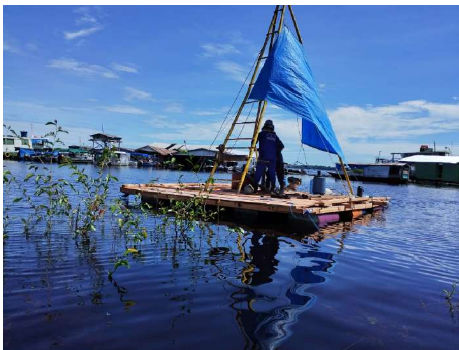
Figura 42 – Realização das sondagens geotécnicas
