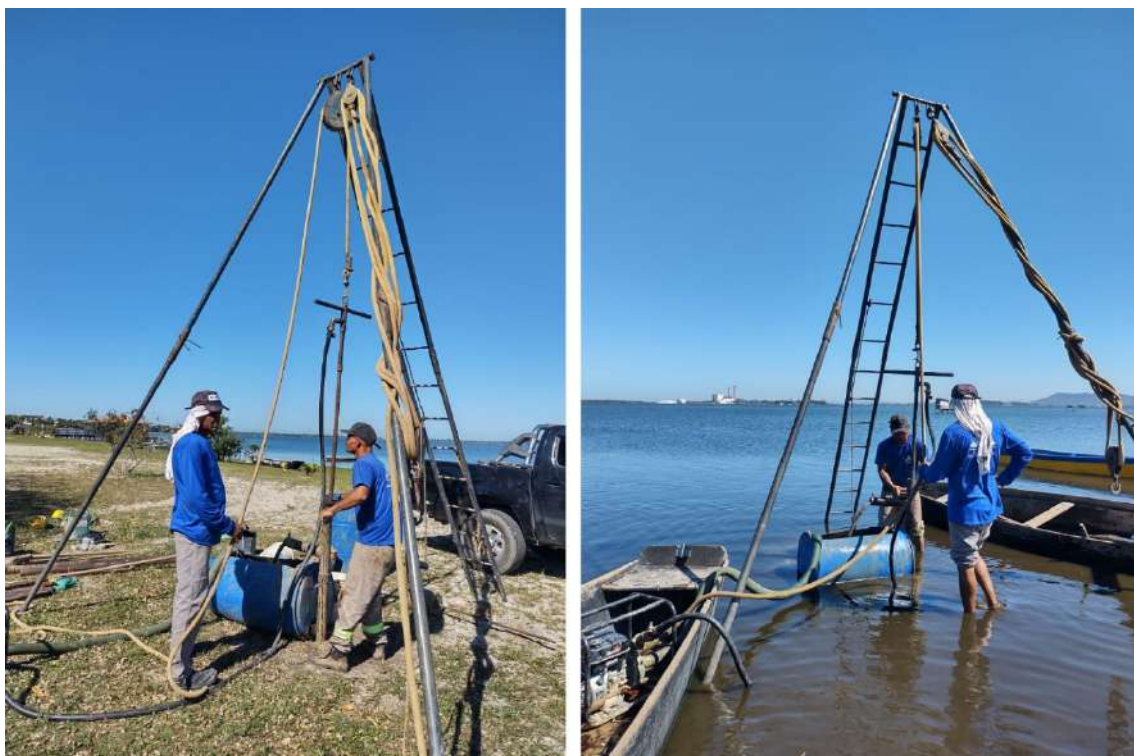
Figura 32 – Realização das sondagens geotécnicas
