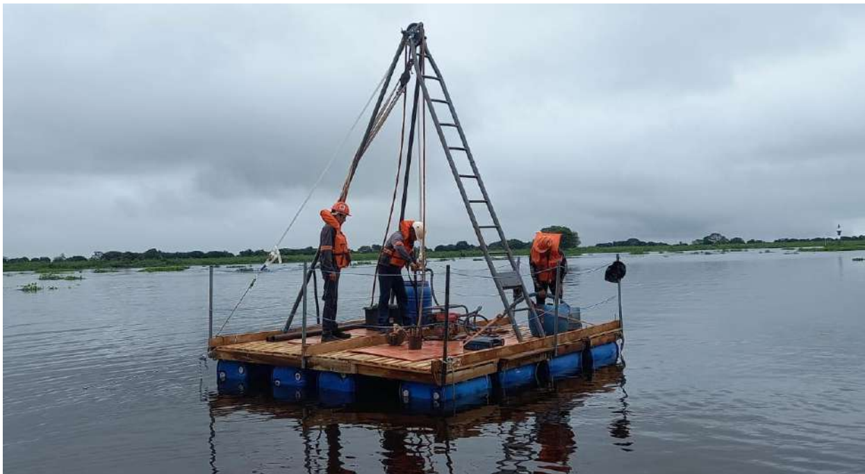
Fig. 7 – avançando a sondagem com circulação de água
