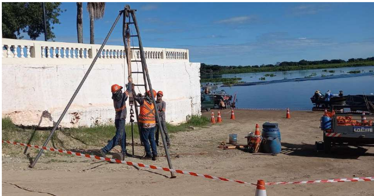
Fig. 5 – sacando as hastes para análise do solo coletado
