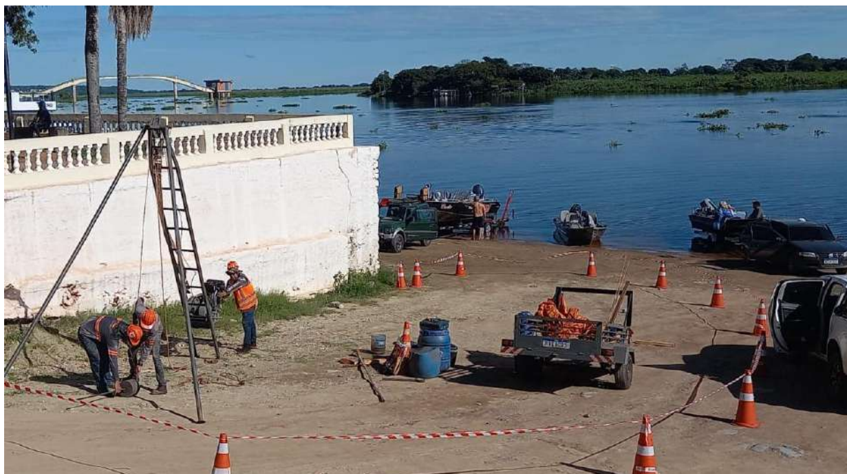
Fig. 3 – Fixando cabo de aço ao peso padrão para iniciar a sondagem
