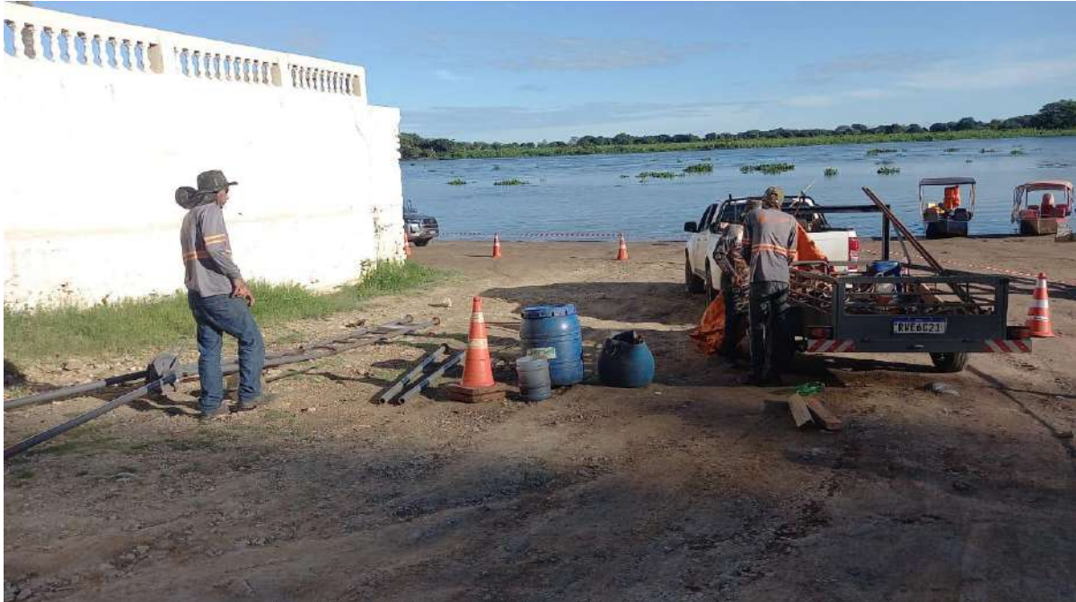
Fig. 1 – iniciando a montagem do equipamento para dar início à sondagem
