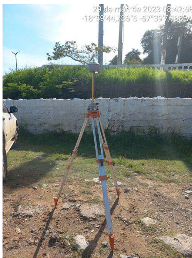
Figura 02: Base instalada próximo a margem direita
