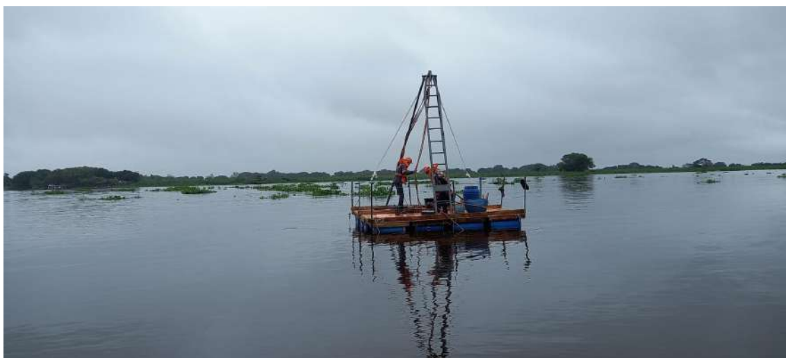
Figura 41 – Realização das sondagens geotécnicas
