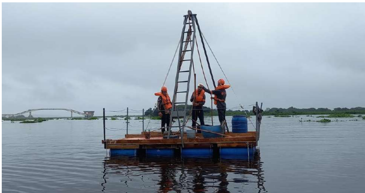
Fig. 9 – fixando as hastes para dar continuidade a sondagem
