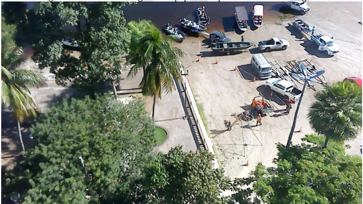
Fig. 2 – montagem do tripé para dar início à sondagem – imagem aérea
