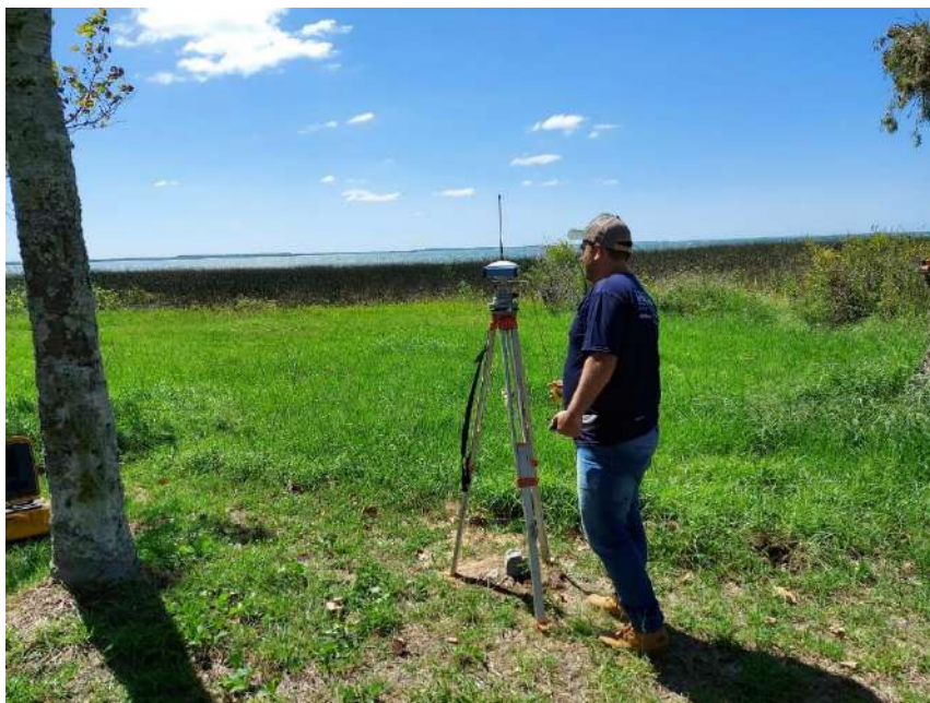
Figura 6 – Equipamento “base” instalado sobre o marco referencial, junto a orla de São Lourenço do Sul.
