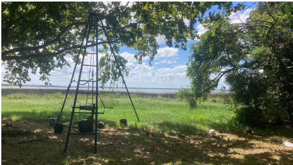
Figura 33 – Realização das sondagens geotécnicas
