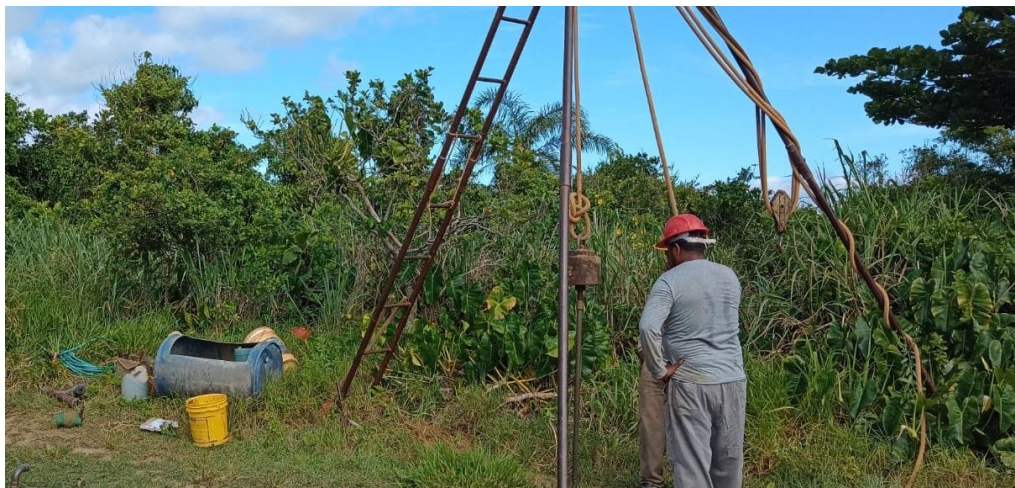
Figura 40 – Realização das sondagens geotécnicas Fonte: Imagem fornecida pela Prefeitura de Peruíbe (2022).
