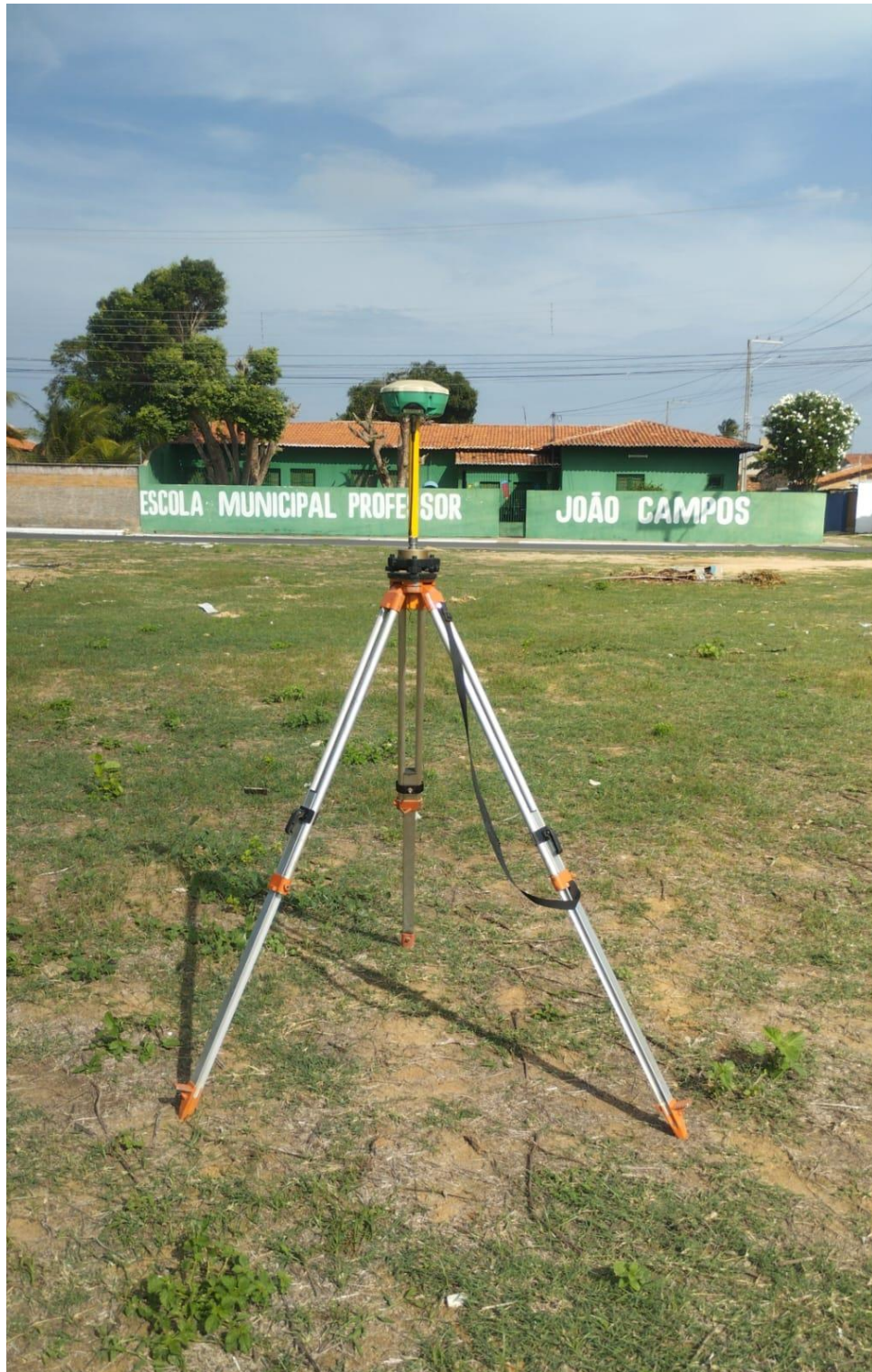
Imagem 2 – Rastreio e implantação de Base Geodésica de apoio – 09.02.2024.
