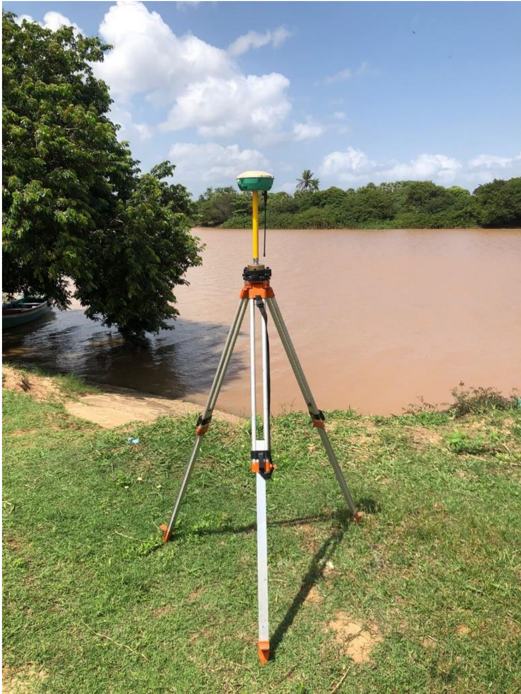
Imagem 1 – Rastreio e implantação de Base Geodésica de apoio – 10.02.204.
