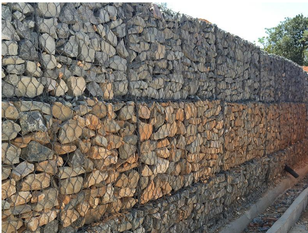
Figura 34 – Muro de gabião do tipo caixa
