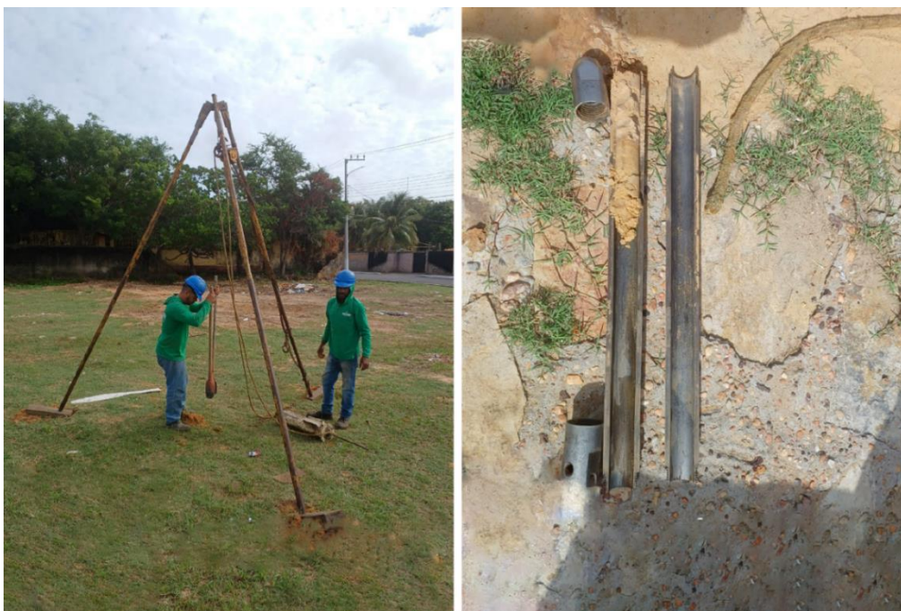
Figura 15 – Realização das sondagens geotécnicas
