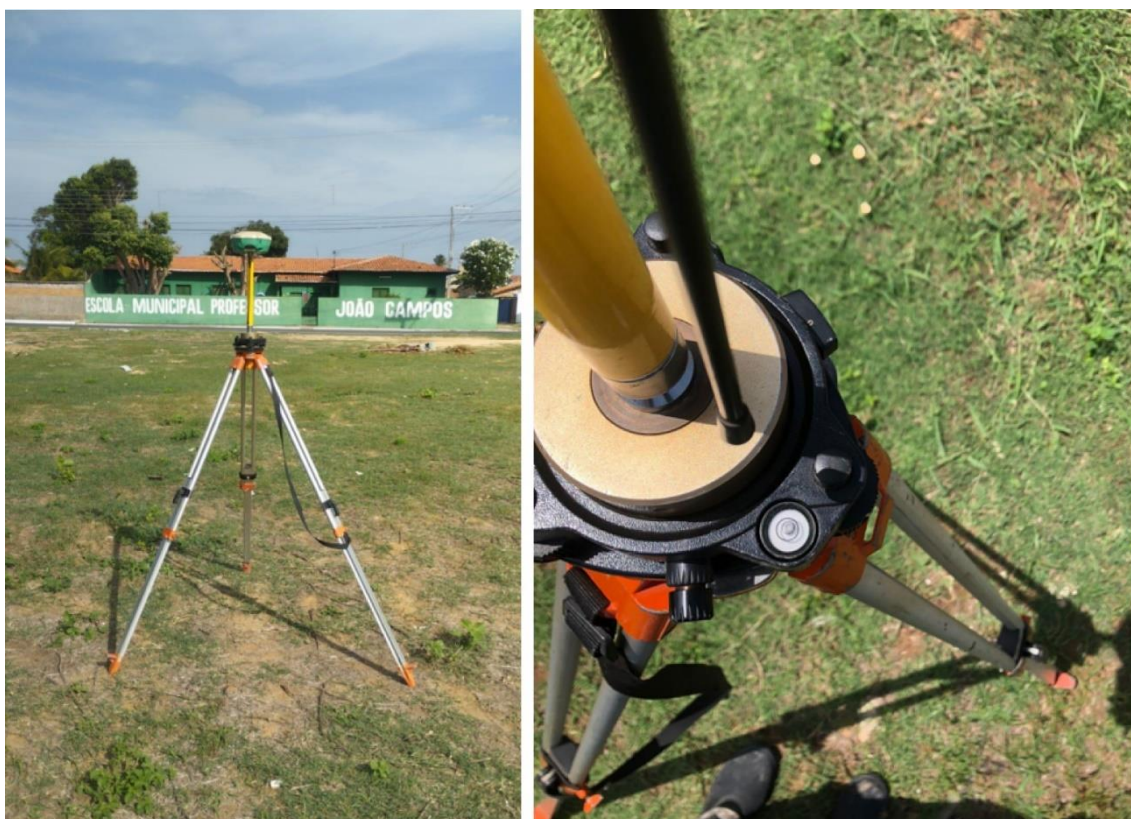
Figura 12 – Realização do levantamento topográfico
