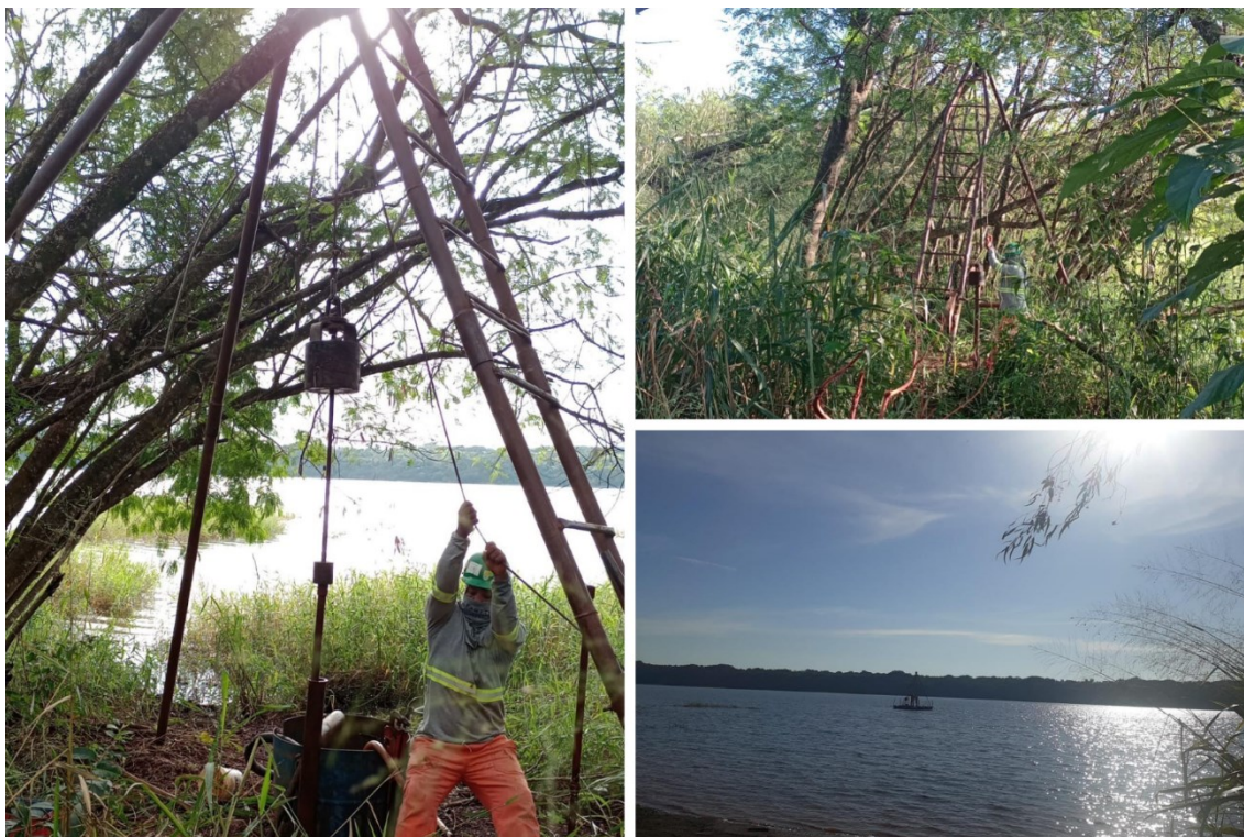
Figura 18 – Realização das sondagens geotécnicas
