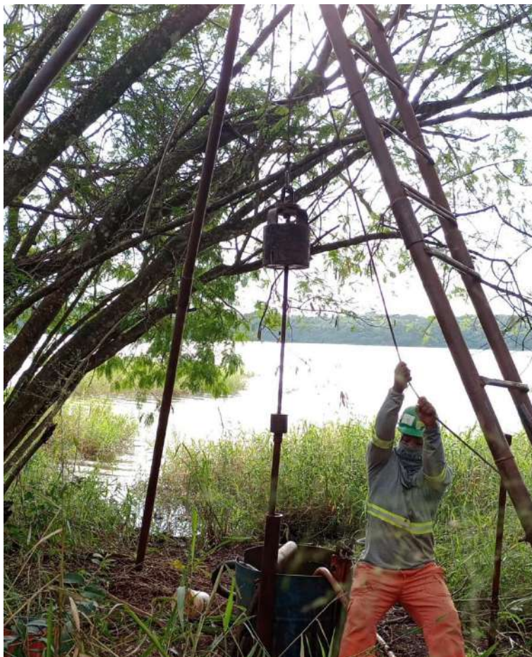
Figura 30 – Realização das sondagens geotécnicas Fonte: Imagem fornecida pela Prefeitura de Foz do Iguaçu (2023).
