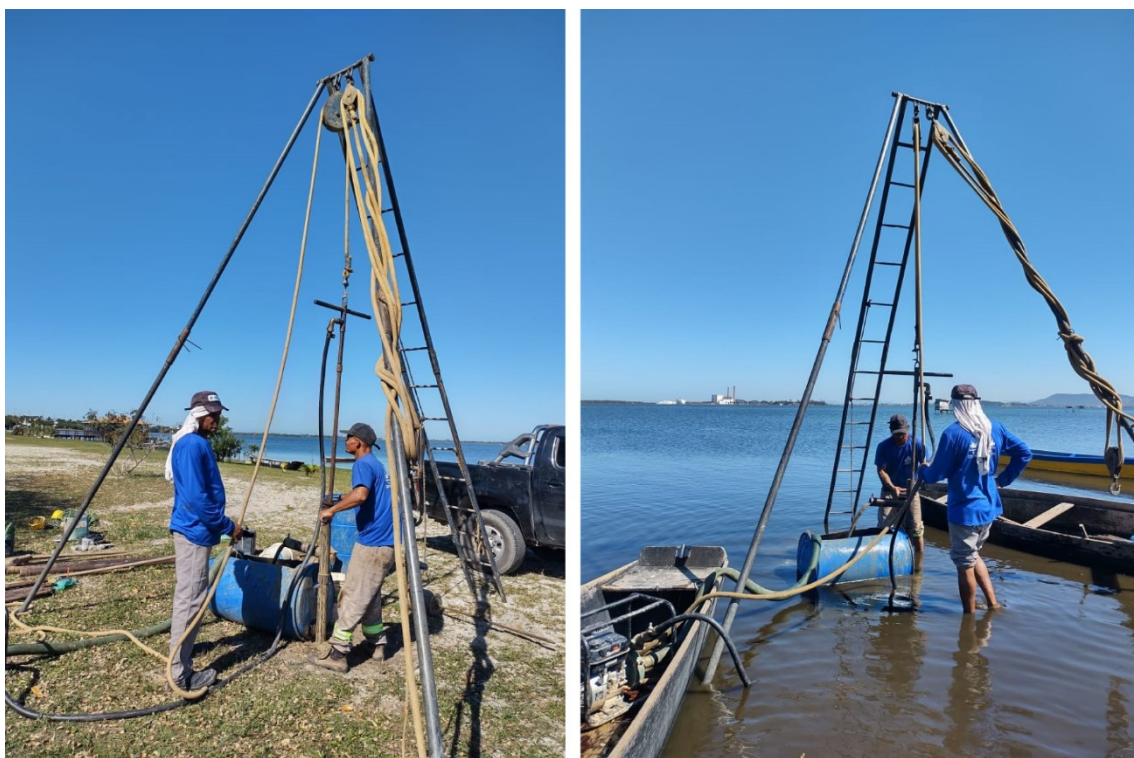
Figura 17 – Realização das sondagens geotécnicas
