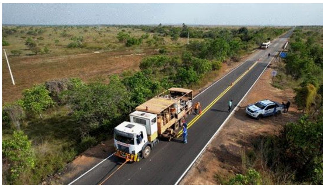
Imagem 4: BR-174 em obras em Roraima
