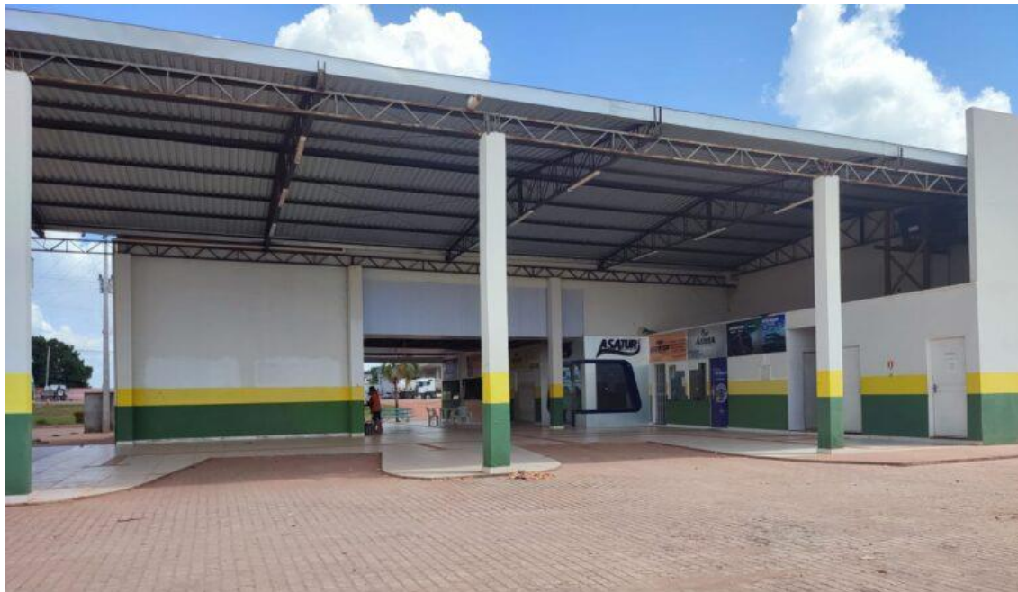
Imagem 29: Terminal Rodoviário de Rorainópolis-RR
