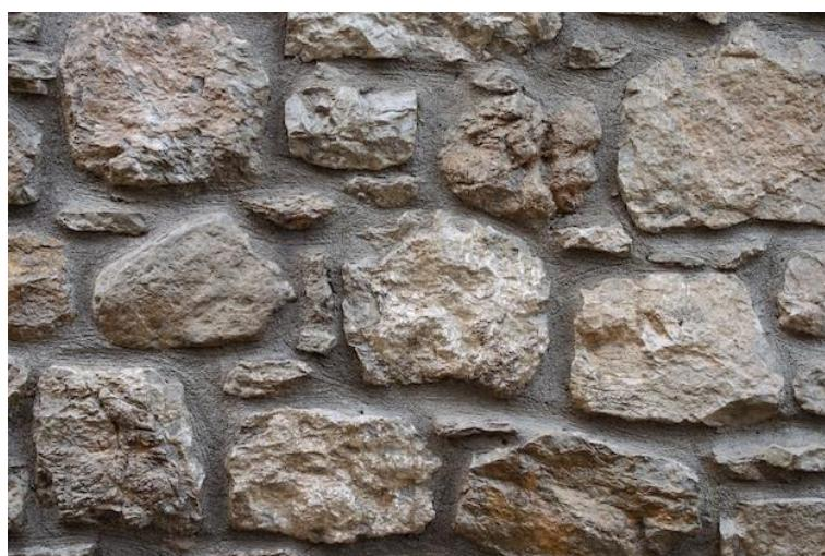
Figura 34 – Muro de pedra argamassada
