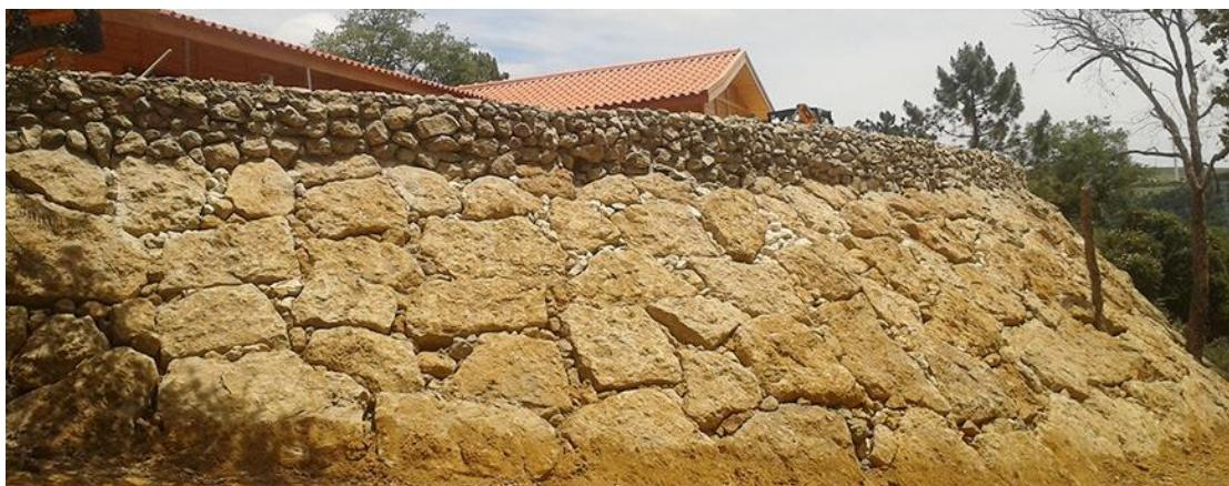
Figura 36 – Taludes com pedra argamassada
