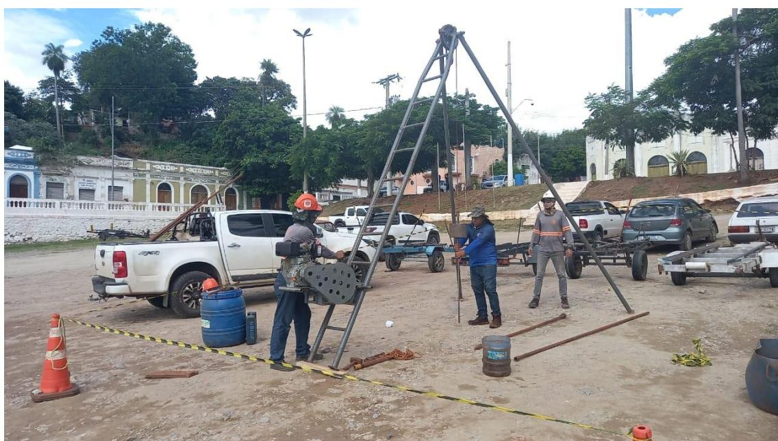
Figura 21 – Realização das sondagens geotécnicas
