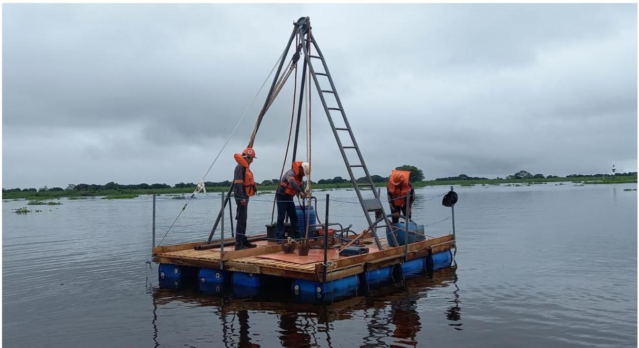
Fig. 7 – avançando a sondagem com circulação de água
