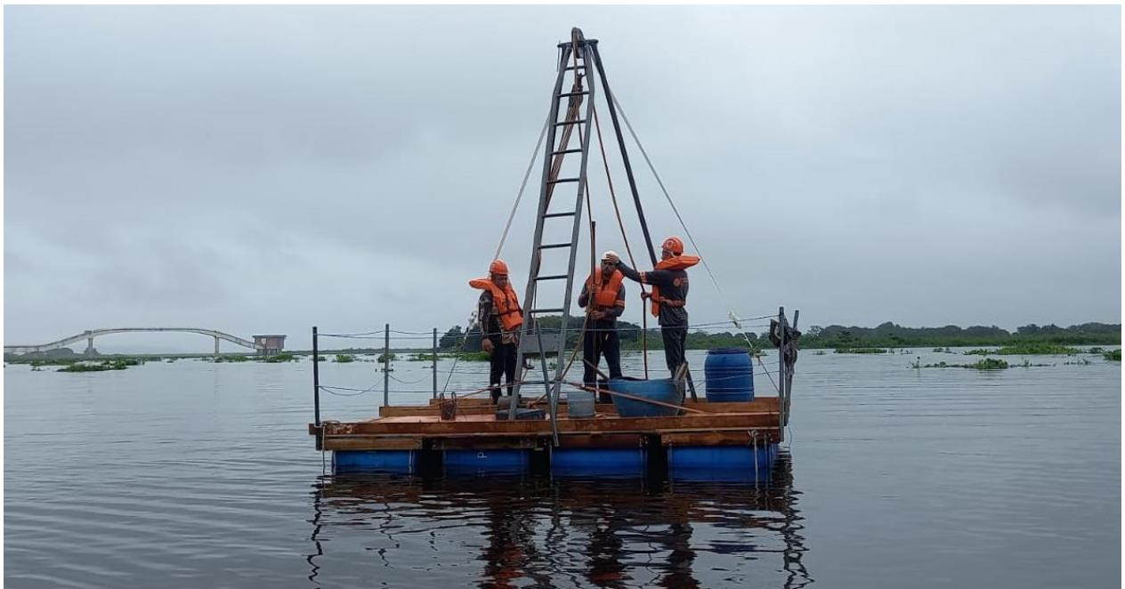
Fig. 9 – fixando as hastas para dar continuidade a sondagem
