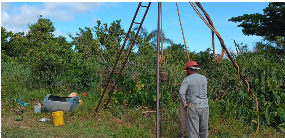
Figura 23 – Realização das sondagens geotécnicas
