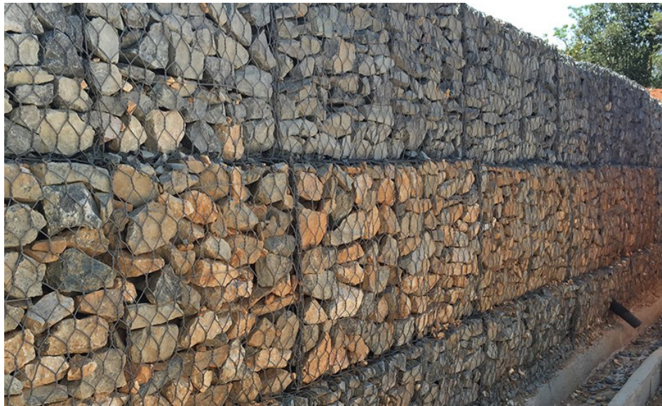
Figura 40 – Muro de gabião tipo caixa
