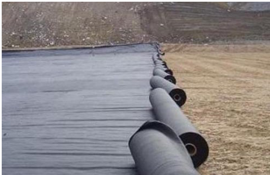
Figura 43 – Manta geotêxtil não tecida
