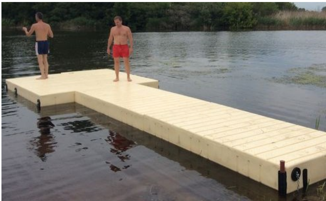
Figura 59 – Exemplo de pier de PVC no Brasil
