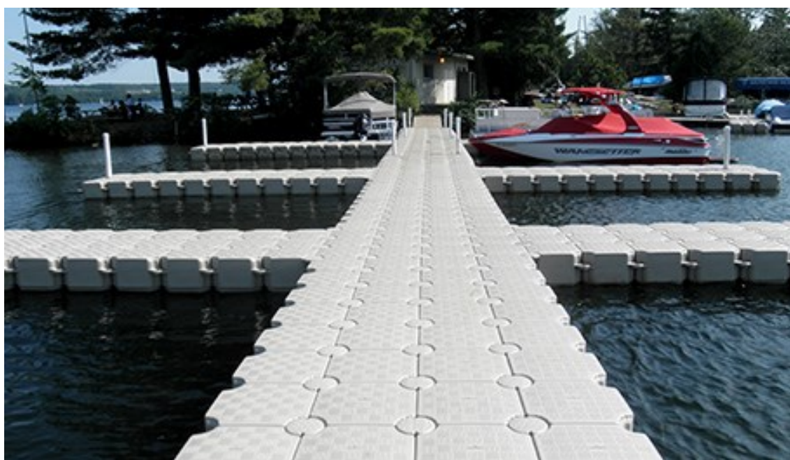
Figura 35 – Píer flutuante e modular de poliestireno na Espanha
