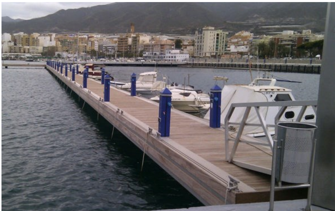
Figura 34 – Píer fixo de alumínio e madeira na Espanha
