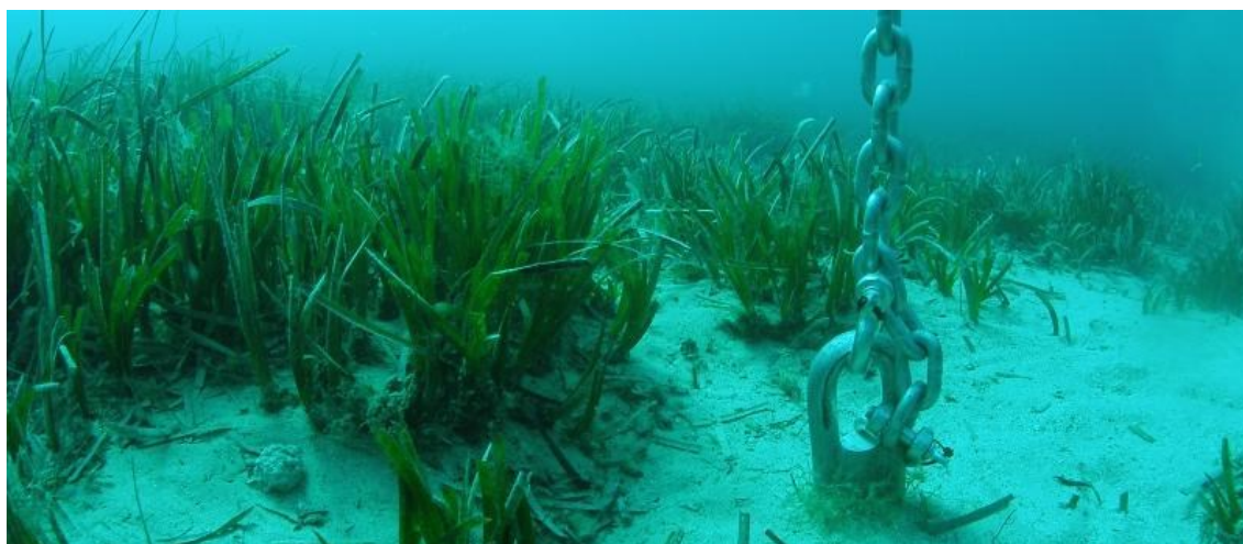
Figura 28 – Ancoragem ecológica das boias de amarração na Espanha
