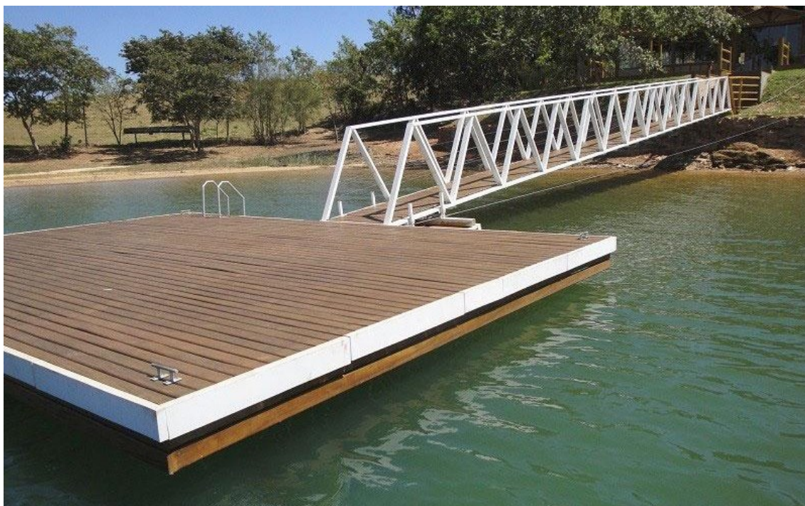
Figura 58 – Píer flutuante em estrutura de madeira no Brasil
