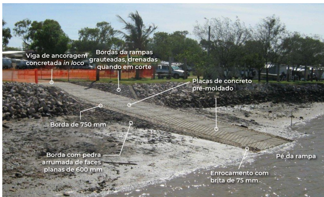
Figura 43 – Rampa náutica e seus componentes na Austrália Fonte: Queensland (2015a). Elaboração: LabTrans/UFSC (2022)
