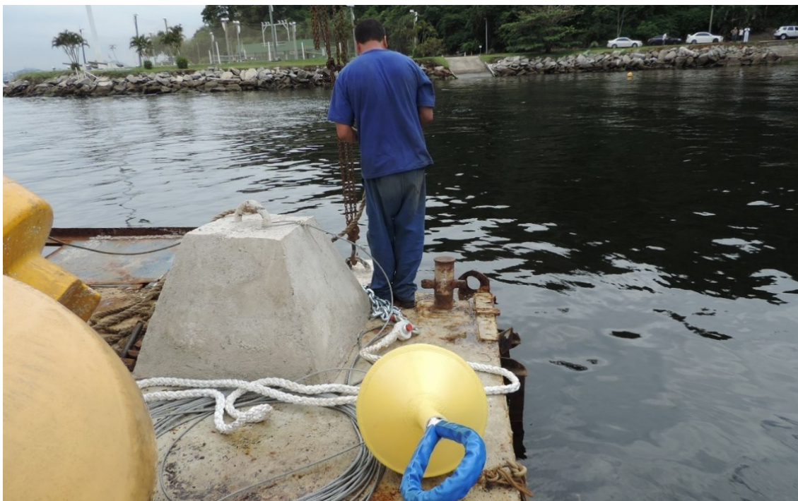
Figura 53 – Conjunto peso de concreto (poita) e boia de amarração no Brasil
