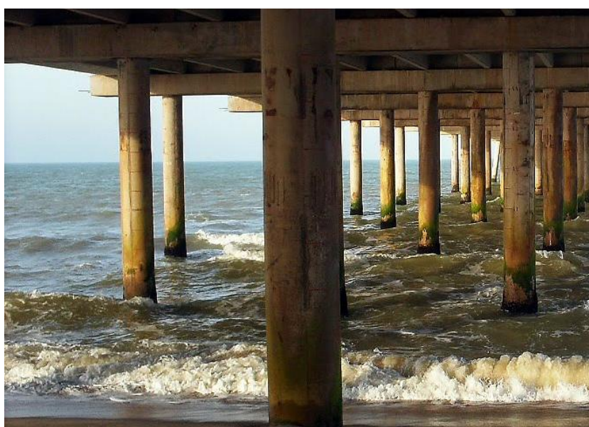
Figura 47 – Pilares de concreto expostos a água salgada
