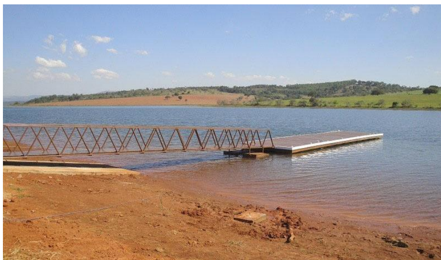
Figura 55 – Exemplo de píer flutuante em madeira
