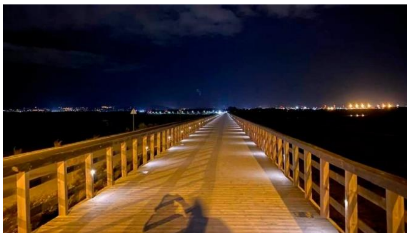
Figura 64 – Projetores encastrados na estrutura de píer
