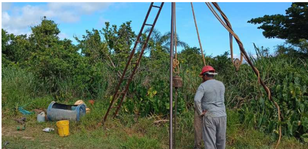
Figura 40 – Realização das sondagens geotécnicas
