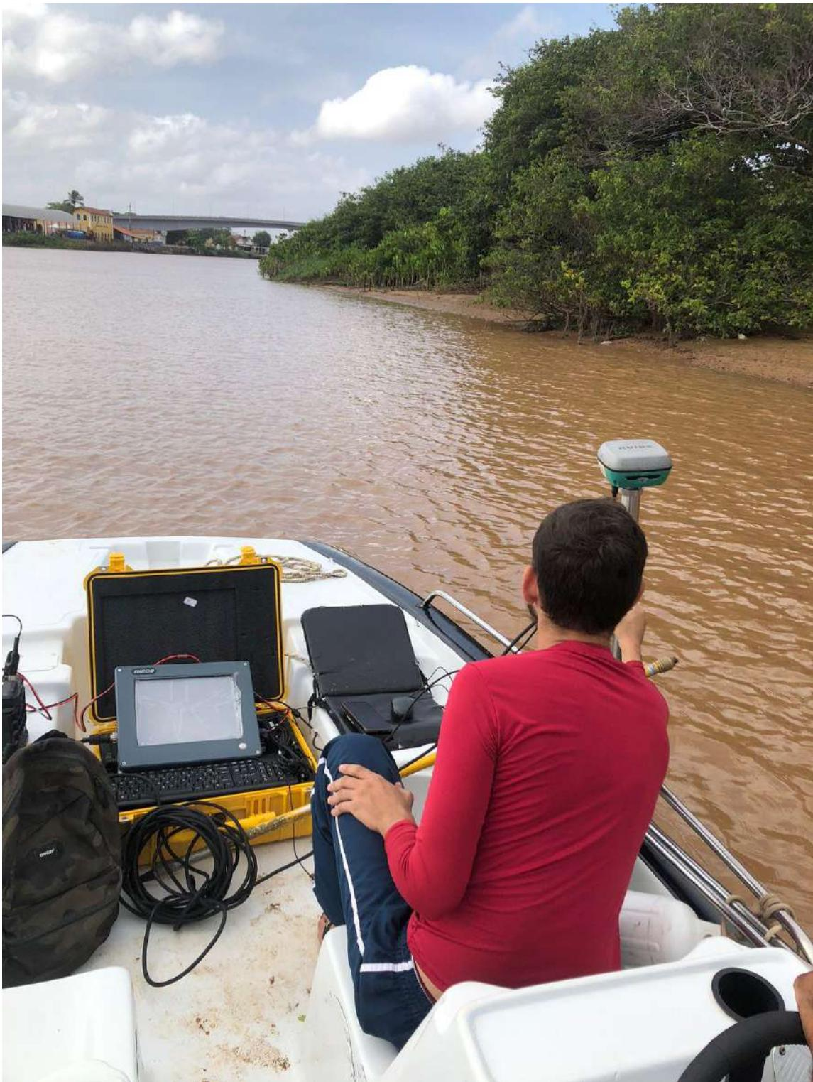
Imagen 5 – Execução e acompanhamento da batimetria com o ecobatímetro SOUTH SDE-28S+.
