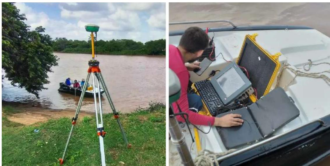
Figura 32 – Realização dos levantamentos batimétrico e topográfico
