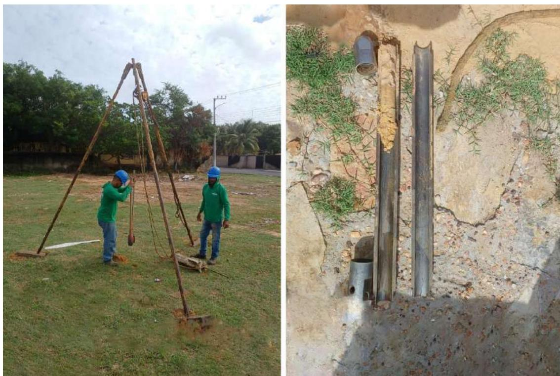
Figura 33 – Realização das sondagens geotécnicas
