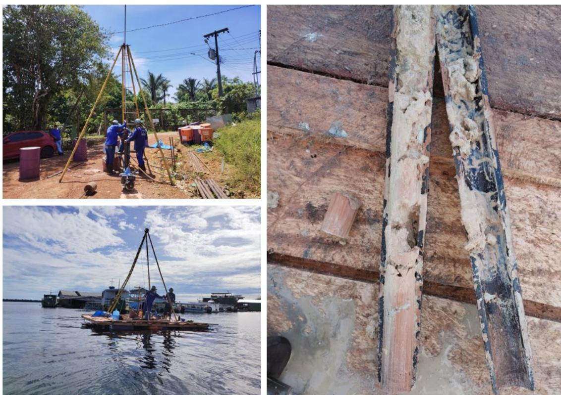
Figura 19 – Realização das sondagens geotécnicas
