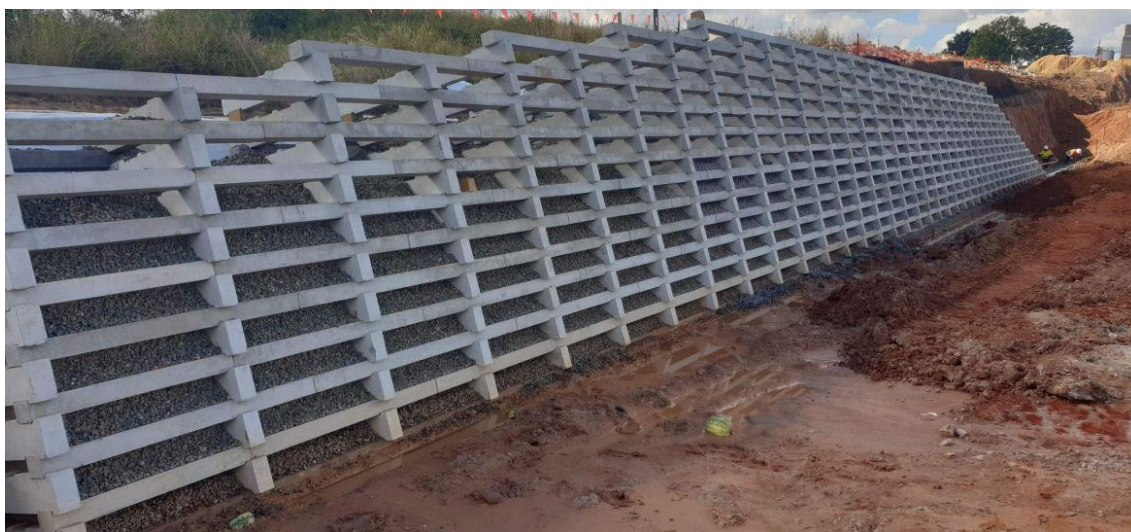
Figura 36 – Muro de contenção ( Crib-Wall )
