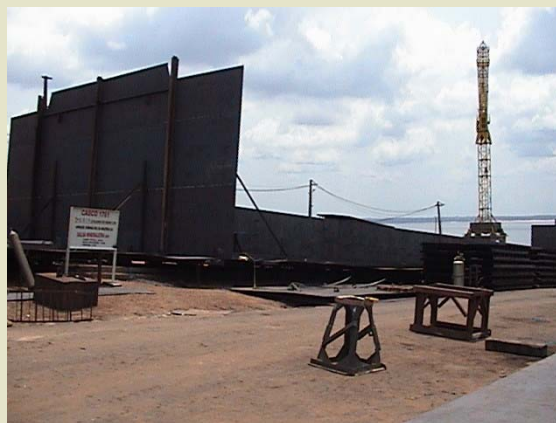
Detalhes de construção de 2 balsas minareleiras tipo box.
