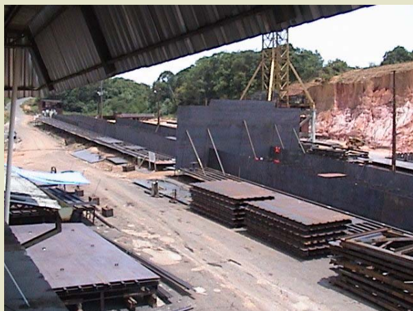
Detalhes de construção de 2 balsas minareleiras tipo box.
