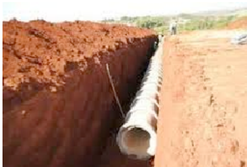
Tubo de concreto armado D=80cm
