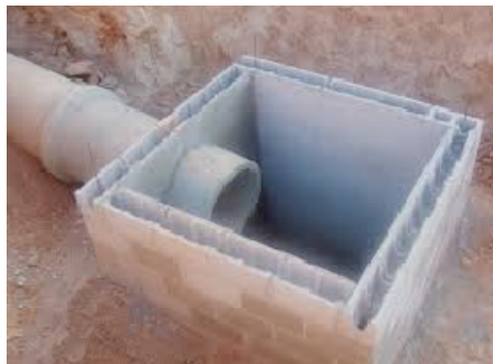
Caixa em alvenaria estrutural
