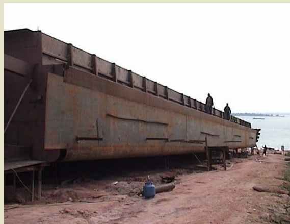
Costado do ERA - 105
