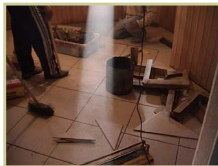
Execução do Piso da Cozinha
