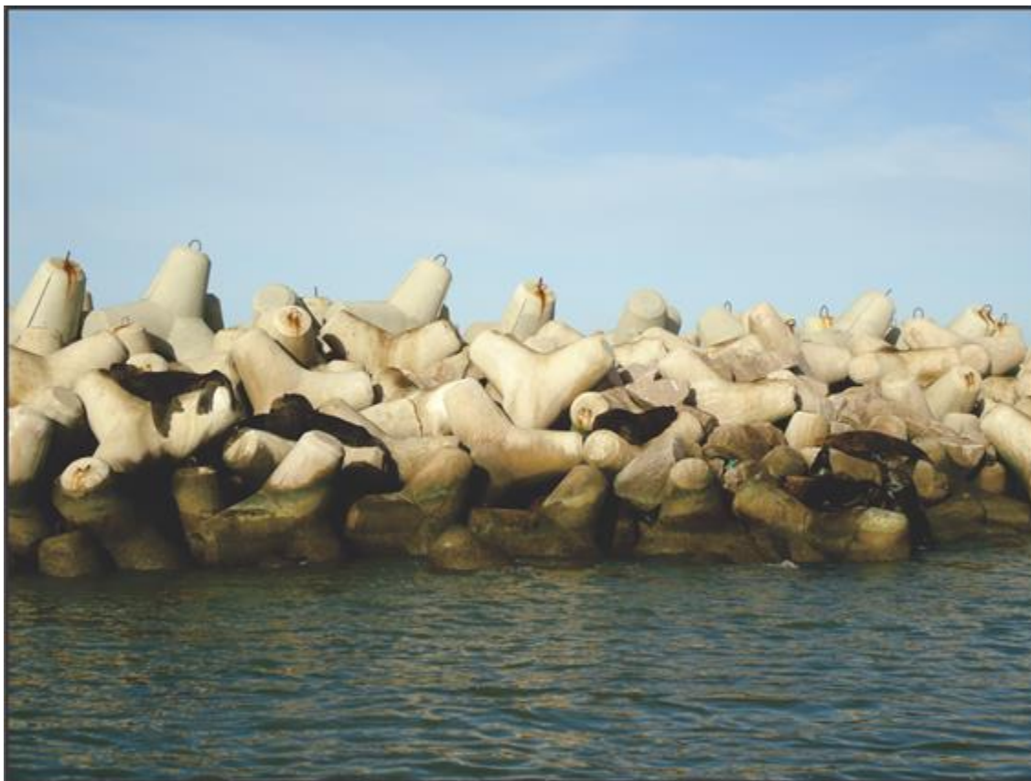
Figura 29. Tetrápodes Utilizados para Manter o Canal
