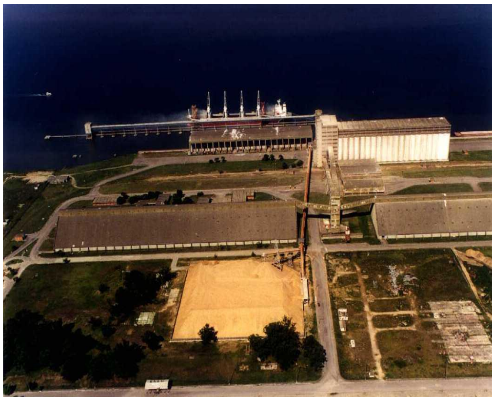
Figura 95. Pátio de Armazenagem de Cavacos de Madeira no Tergrasa e Conexão por Correia Transportadora com o Cais
