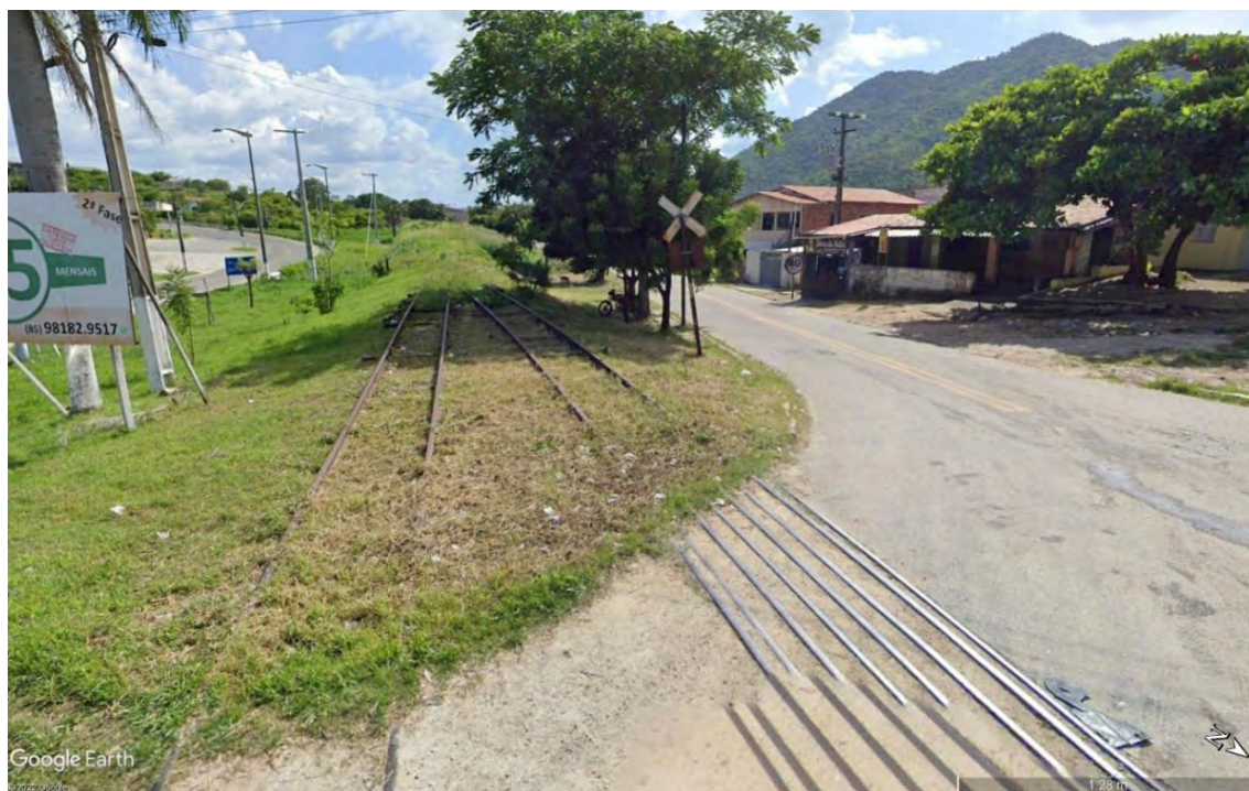
Figura 179 – Situação do segmento em Guaiúba (CE) – 2022
