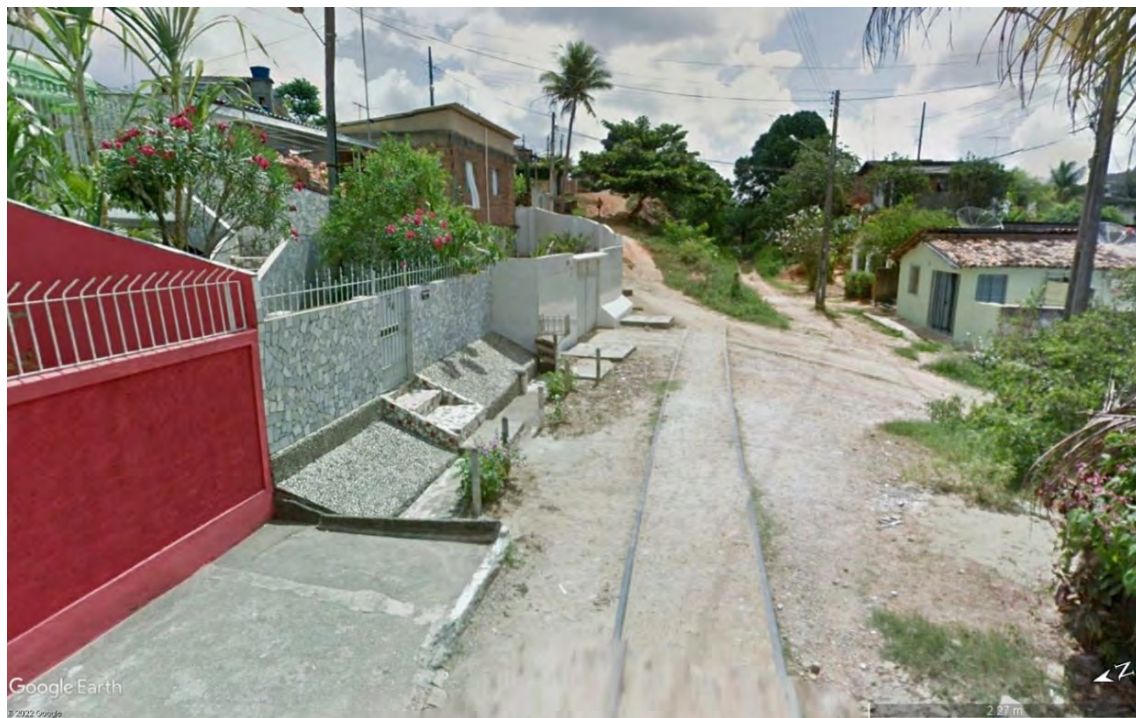
Figura 202 – Situação de segmento em Jaboatão dos Guararapes (PE) – 2012
