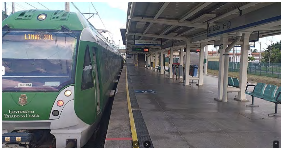
Figura 184 – Estação Vila das Flores
