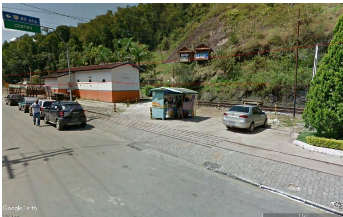
Figura 224 – Situação de segmento em Marechal Floriano (ES) – 2012
