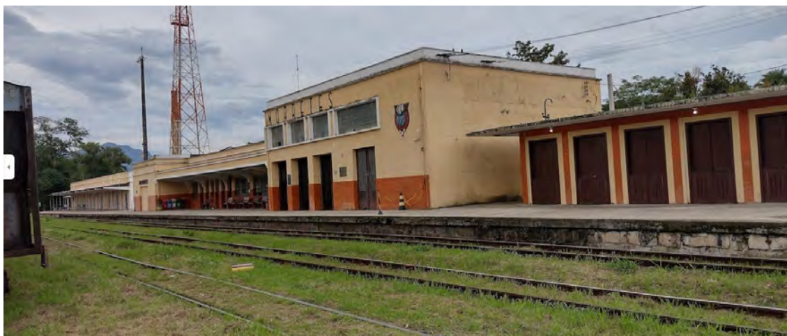
Figura 96 – Plataforma de embarque da Estação Morretes
