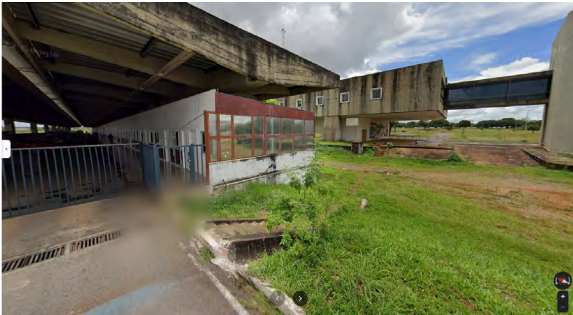
Figura 115 – Estação Ferroviária Brasília
