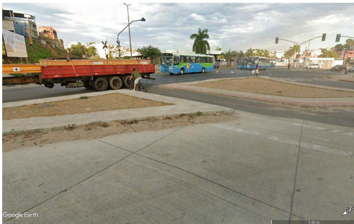
Figura 226 – Situação de segmento totalmente urbanizado e pavimentado em Cariacica (ES) – 2022
