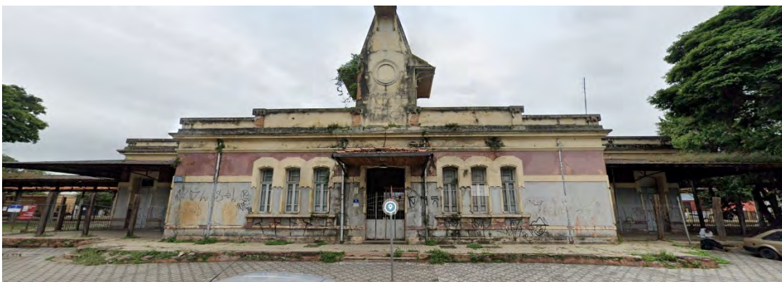
Figura 50 – Visão da entrada da Estação Taubaté
