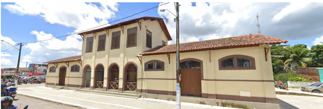
Figura 209 – Estação Ferroviária de Moreno
