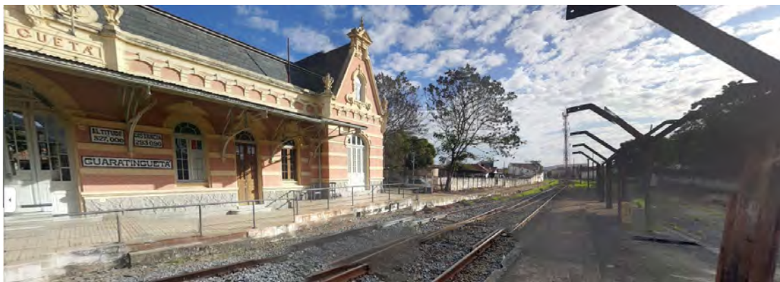
Figura 56 – Visão da plataforma de embarque da Estação Guaratinguetá
