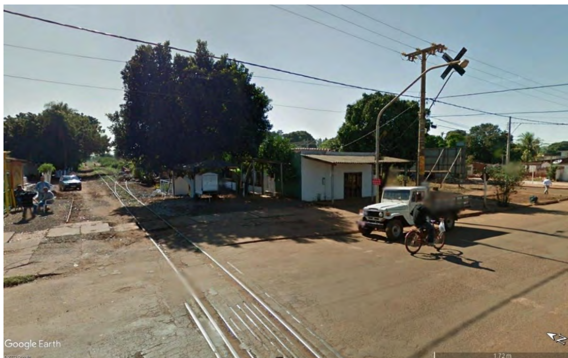
Figura 158 – Situação de segmento em Sidrolândia (MS) – 2012
