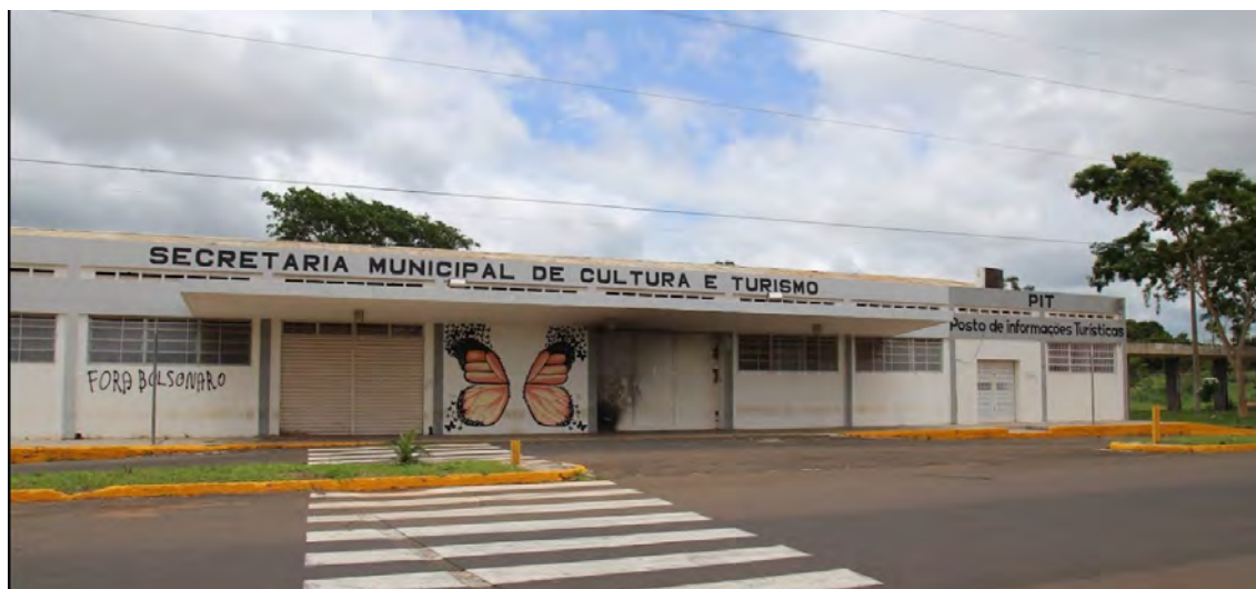
Figura 102 – Estação de Birigui
