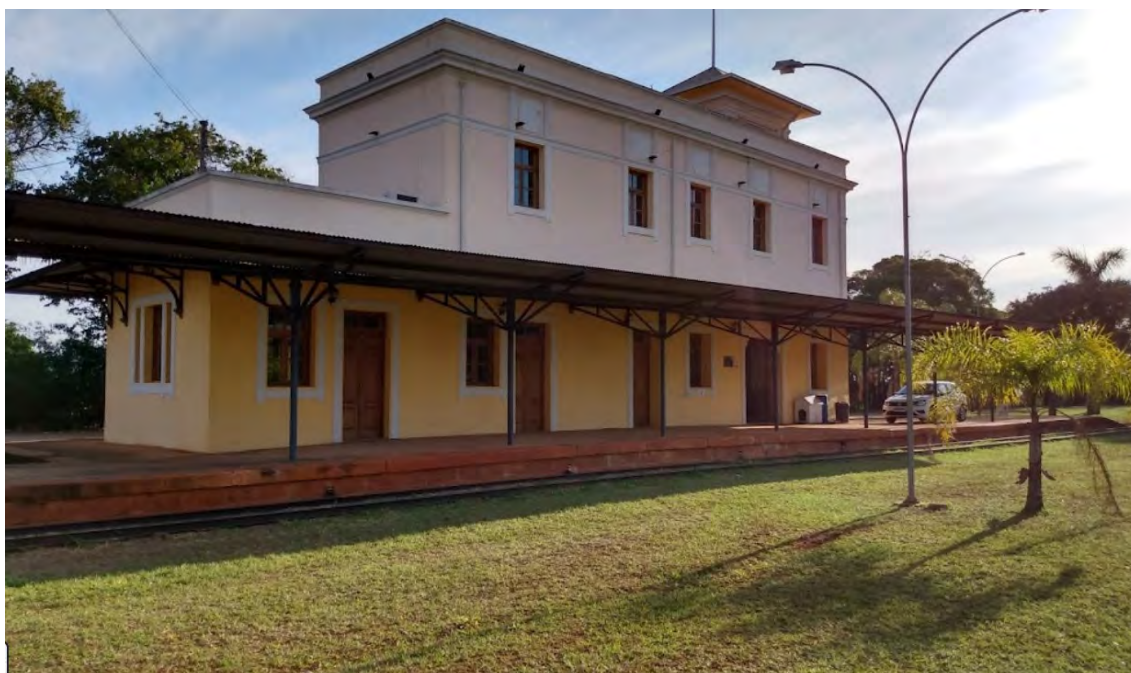
Figura 31 – Plataforma de embarque da Estação de Ourinhos
