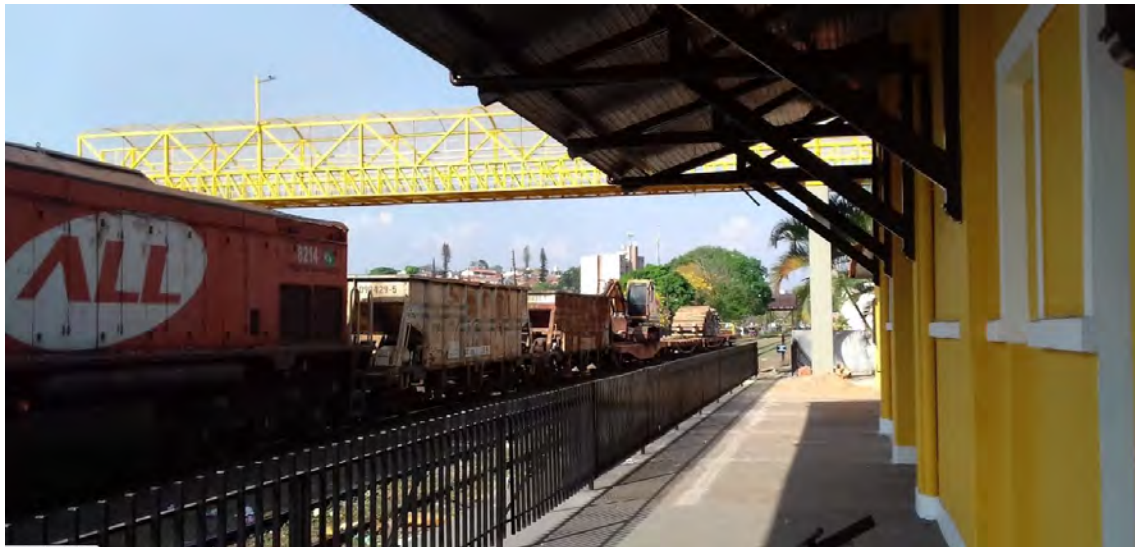
Figura 27 – Vista da plataforma de embarque da Estação Cornélio Procópio (01)
