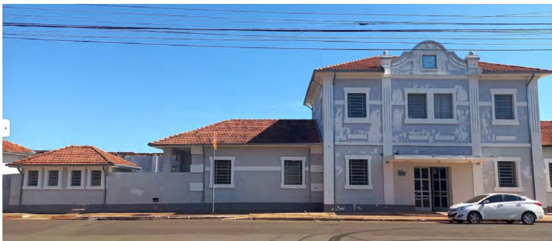
Figura 164 – Estação Campo Grande
