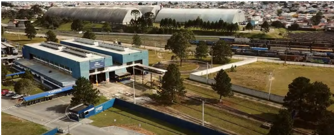
Figura 92 – Visão geral da Estação Iguaçu
