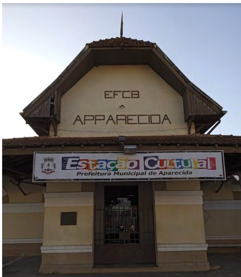
Figura 54 – Visão da entrada da Estação de Aparecida
