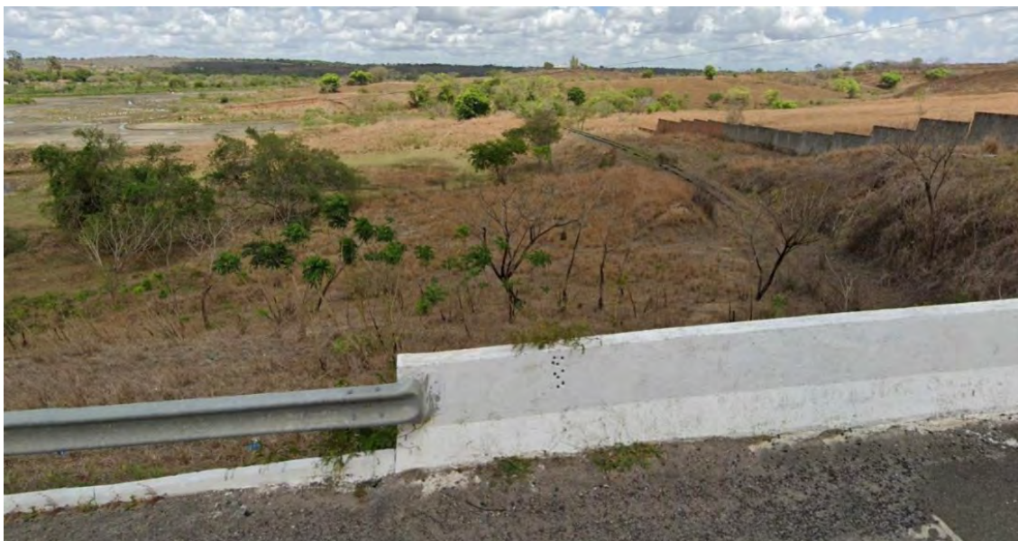
Figura 135 – Segmento ferroviário do trecho analisado - passagem em desnível São Miguel de Taipu (PB)
