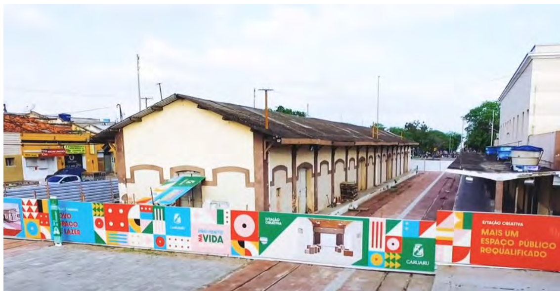
Figura 214 – Estação Ferroviária Caruaru
