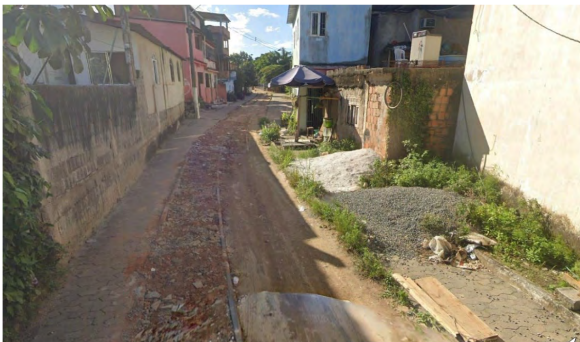
Figura 228 – Situação de segmento em Vila Velha (ES) – 2020
