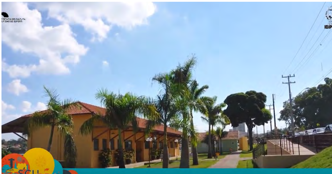
Figura 26 – Vista frontal da Estação Ibioporã
