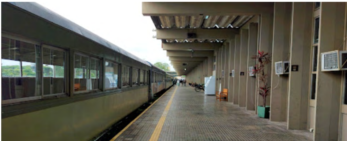
Figura 93 – Plataforma de embarque da Estação Curitiba
