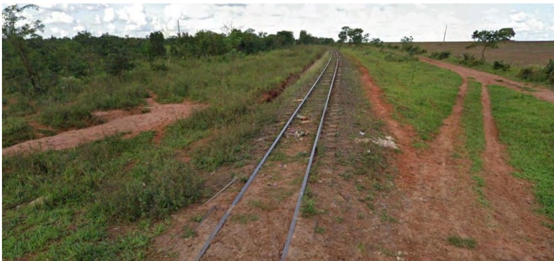
Figura 156 – Situação de segmento em Campo Grande (MS) – 2019
