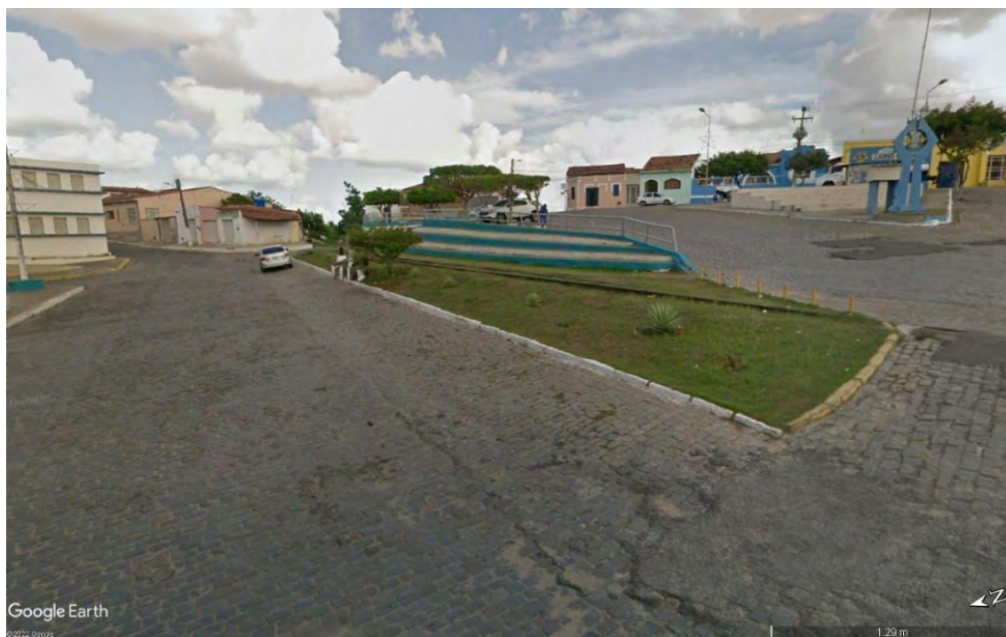
Figura 148 – Situação de segmento em Nova Cruz (RN) – 2018
