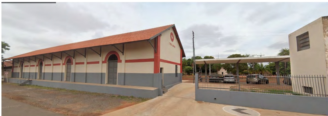
Figura 104 – Estação Três Lagoas
