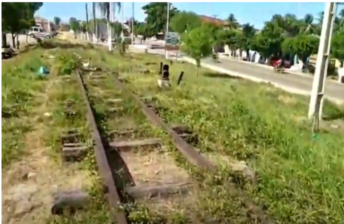
Figura 177 – Situação do segmento em Guaiúba (CE) – 2019
