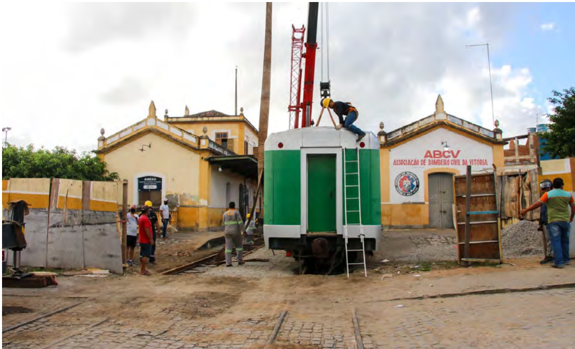
Figura 210 – Estação Ferroviária Vitória de Santo Antão
