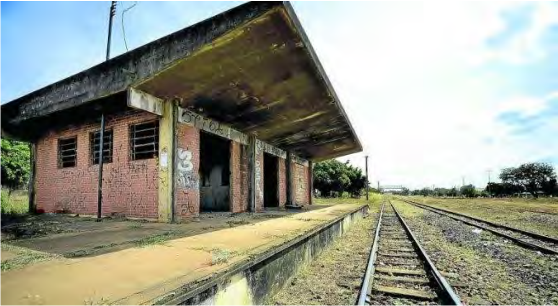
Figura 117 – Visão da plataforma de embarque Estação Jardim Ingá
