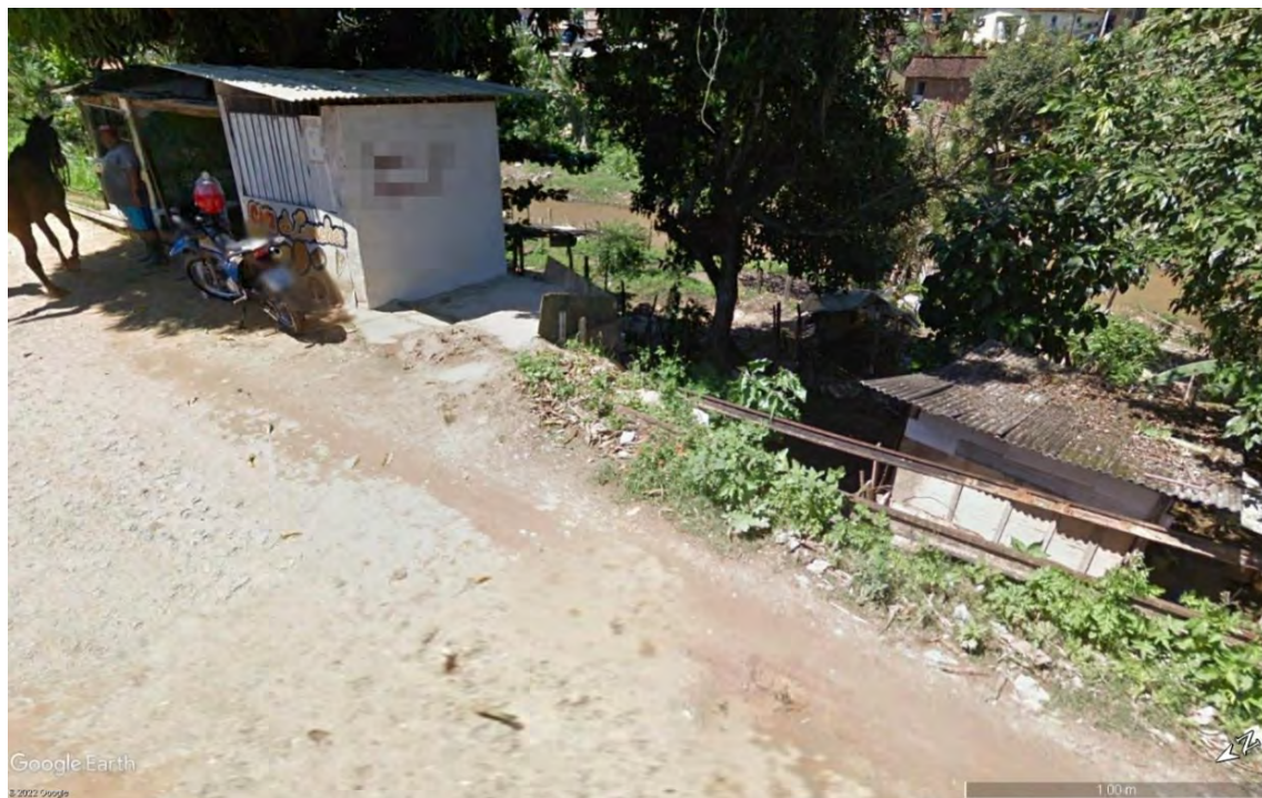
Figura 204 – Situação de segmento em Moreno (PE) – 2019
