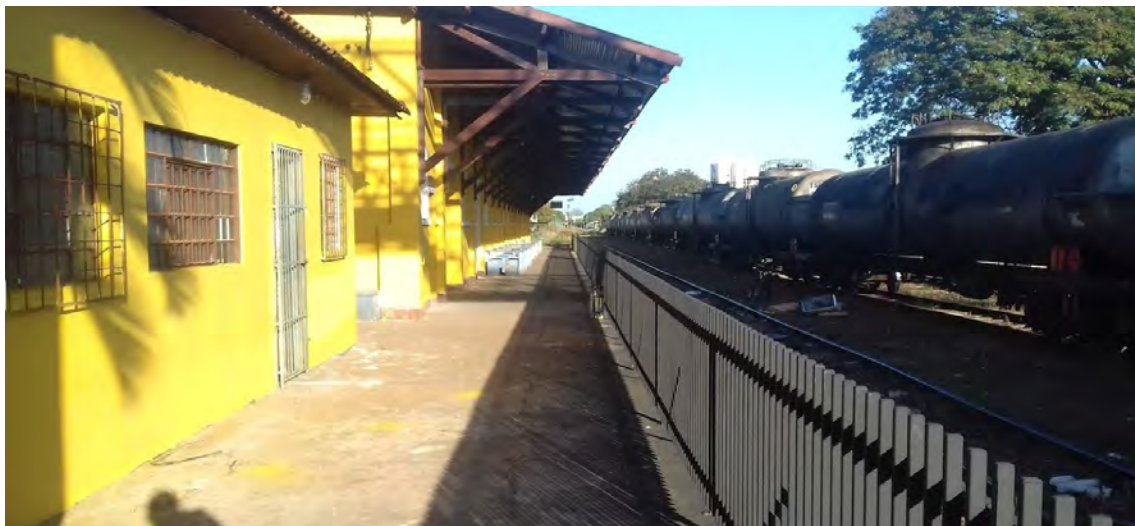
Figura 28 – Vista da plataforma de embarque da Estação Cornélio Procópio (02)
