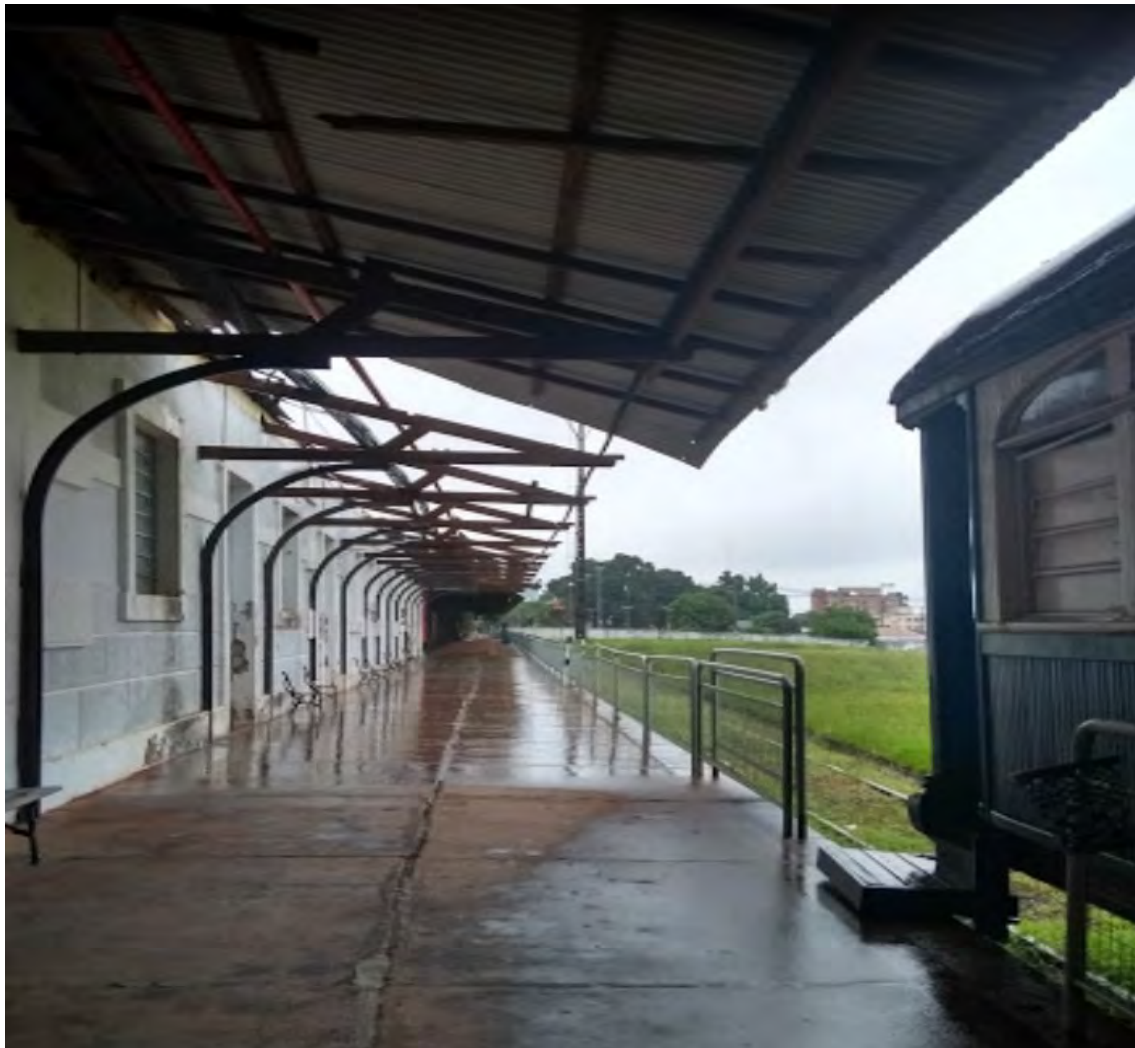
Figura 165 – Plataforma de embarque da Estação Campo Grande
