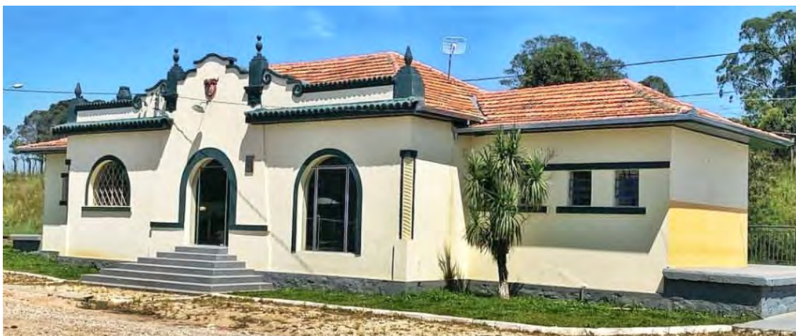
Figura 129 – Fachada da Estação Lapa
