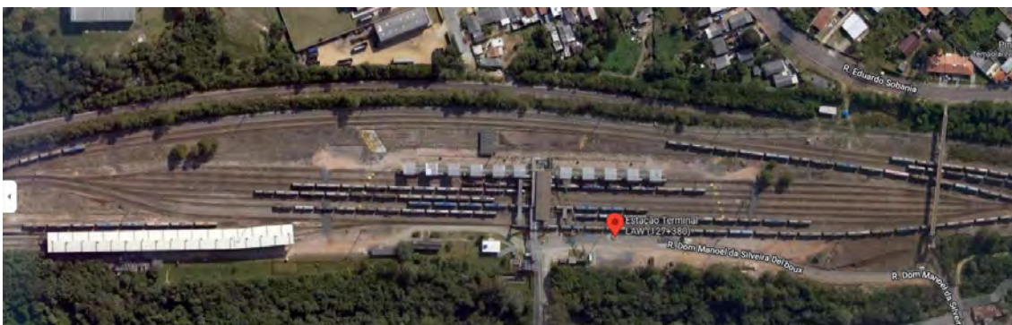
Figura 90 – Visão aérea do pátio Araucária Terminal
