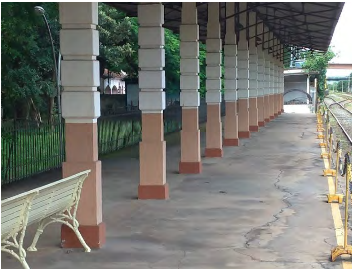
Figura 49 – Visão da plataforma de embarque da Estação São José dos Campos
