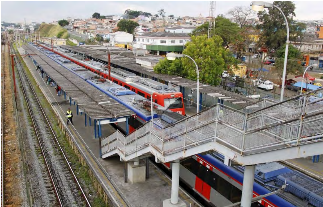
Figura 45 – Estação Engenheiro Manoel Feio
