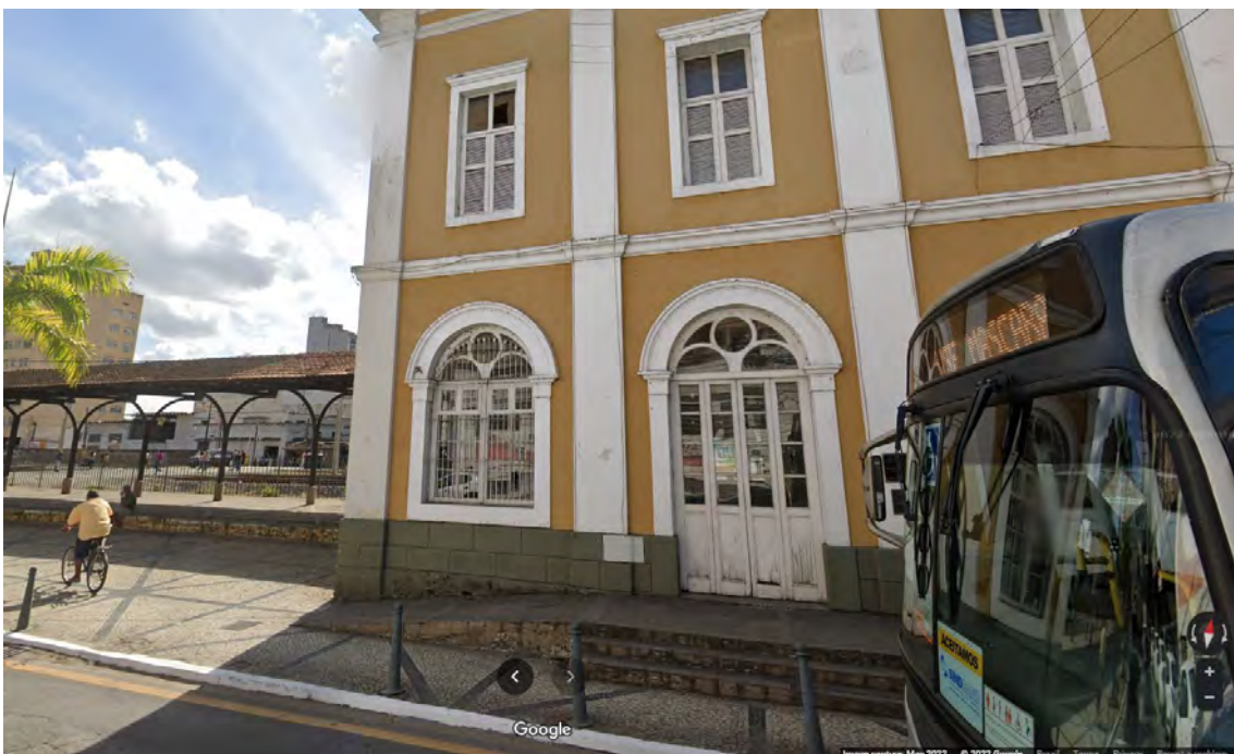
Figura 60 – Visão frontal da Estação Barra Mansa
