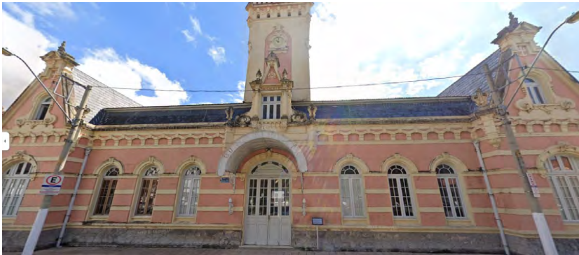
Figura 55 – Visão da entrada da Estação Guaratinguetá
