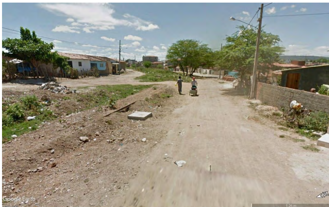
Figura 207 – Situação de segmento em Caruaru (PE) – 2012
