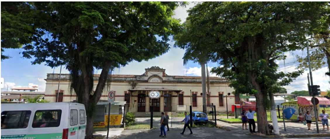
Figura 52 – Visão da entrada da Estação Pindamonhangaba
