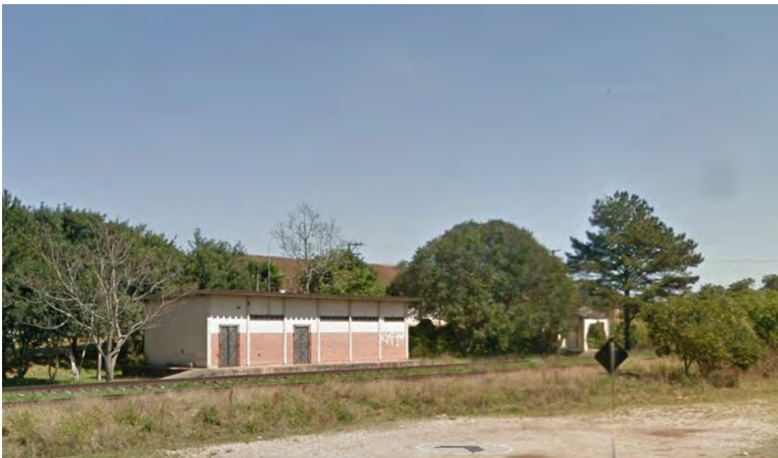
Figura 88 – Armazém Balsa Nova
