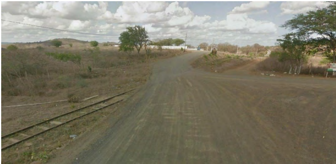
Figura 136 – Segmento ferroviário do trecho analisado em Campina Grande (PB)
