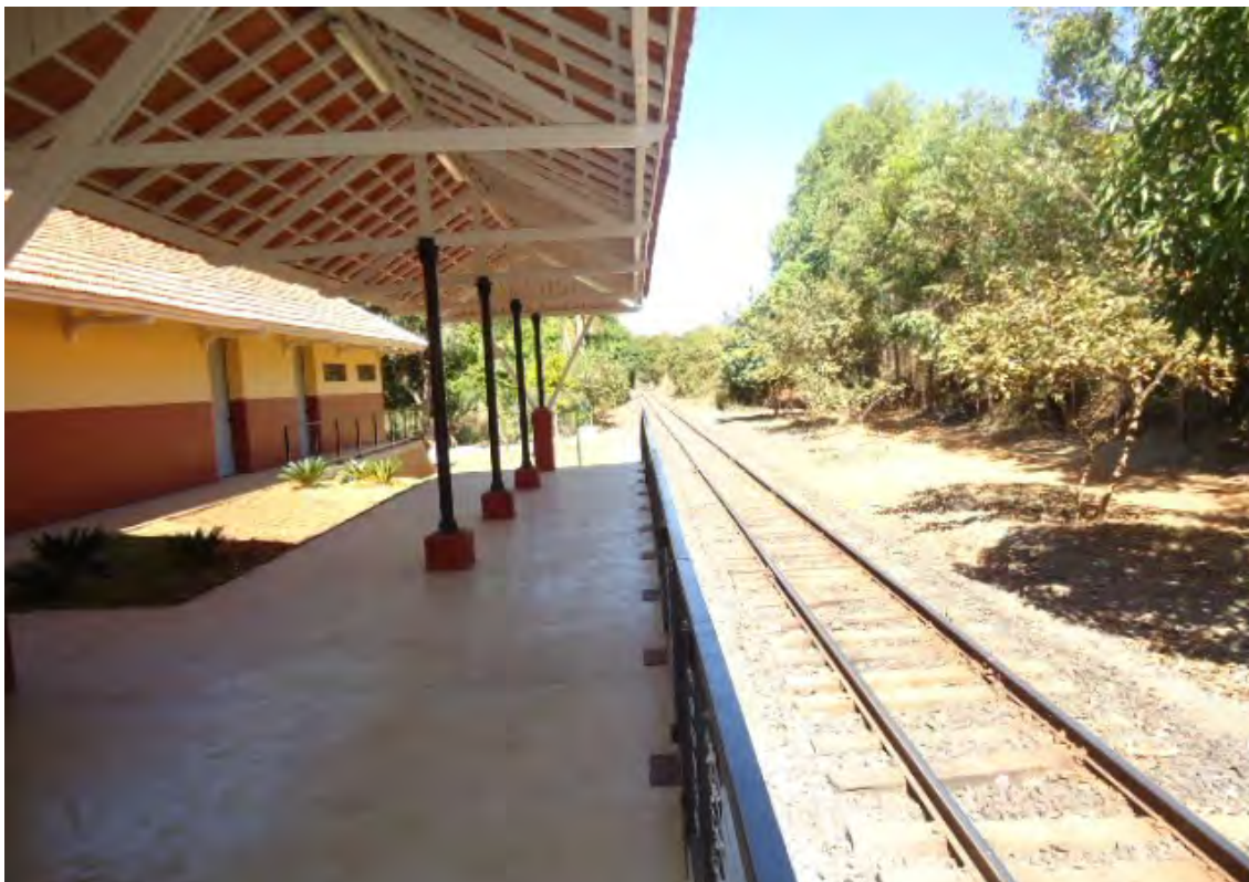
Figura 77 – Plataforma de embarque da Estação Silvânia
