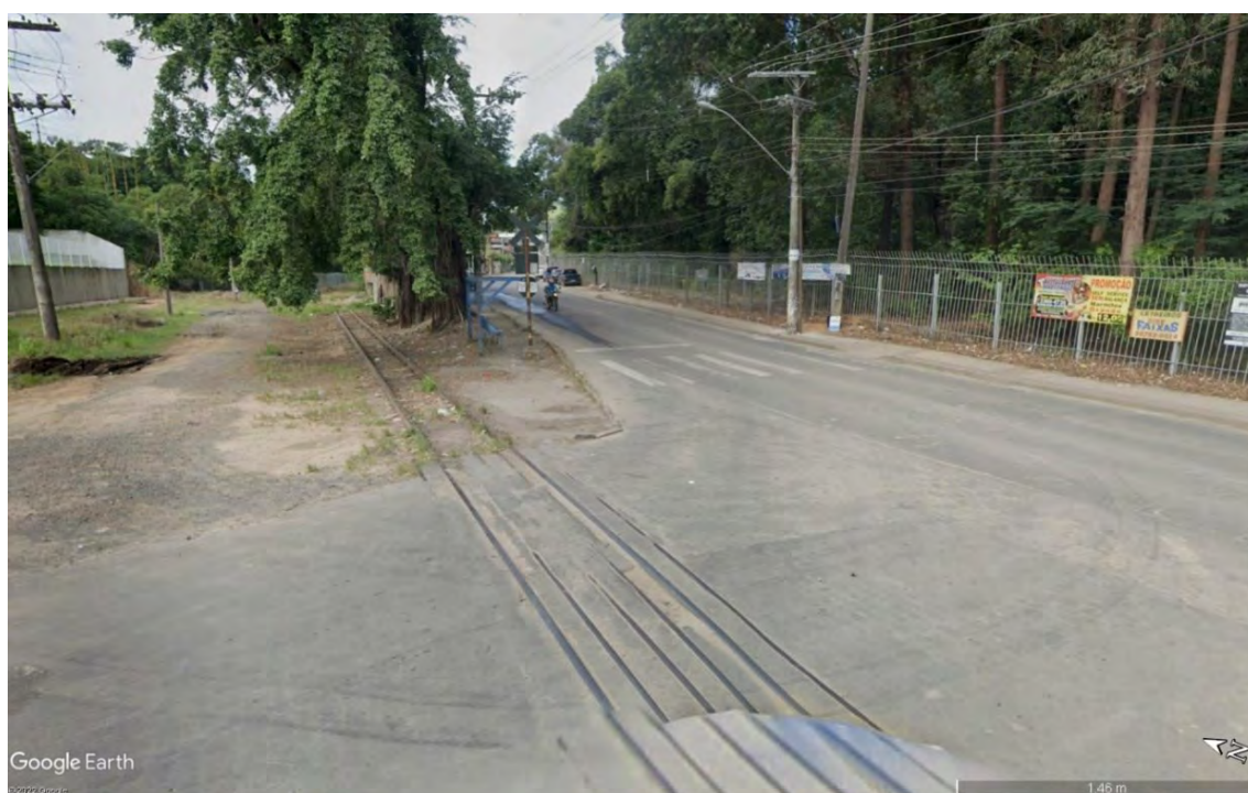
Figura 227 – Situação de segmento em Vila Velha (ES) – 2020
