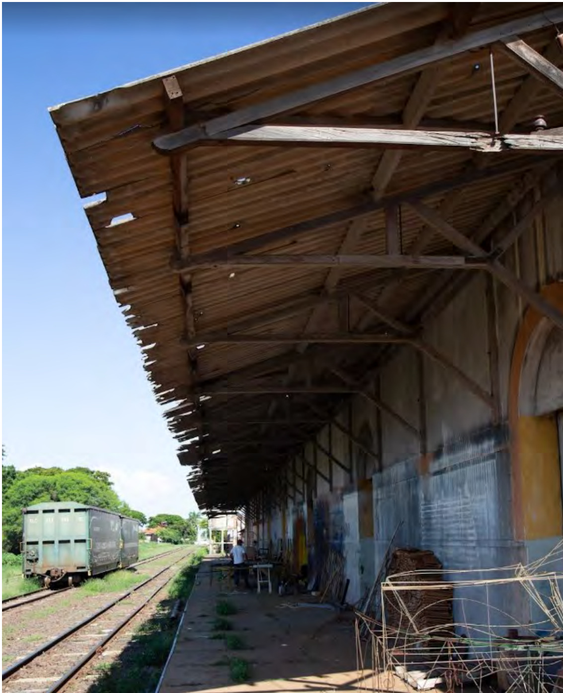
Figura 110 – Plataforma de embarque da Estação Valparaíso
