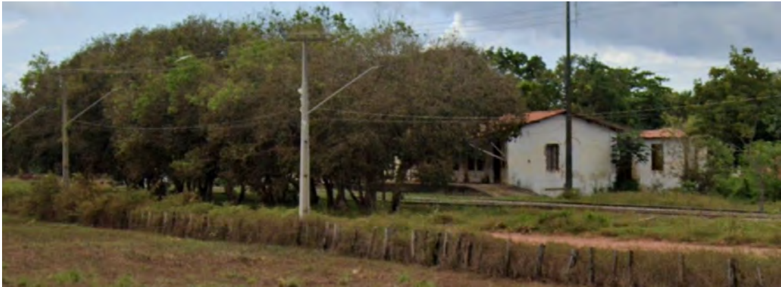
Figura 37 – Estação Itapecuru Mirim (01)
