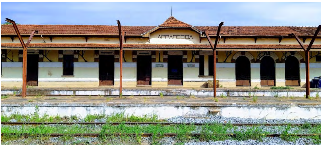
Figura 53 – Visão da plataforma de embarque da Estação Aparecida
