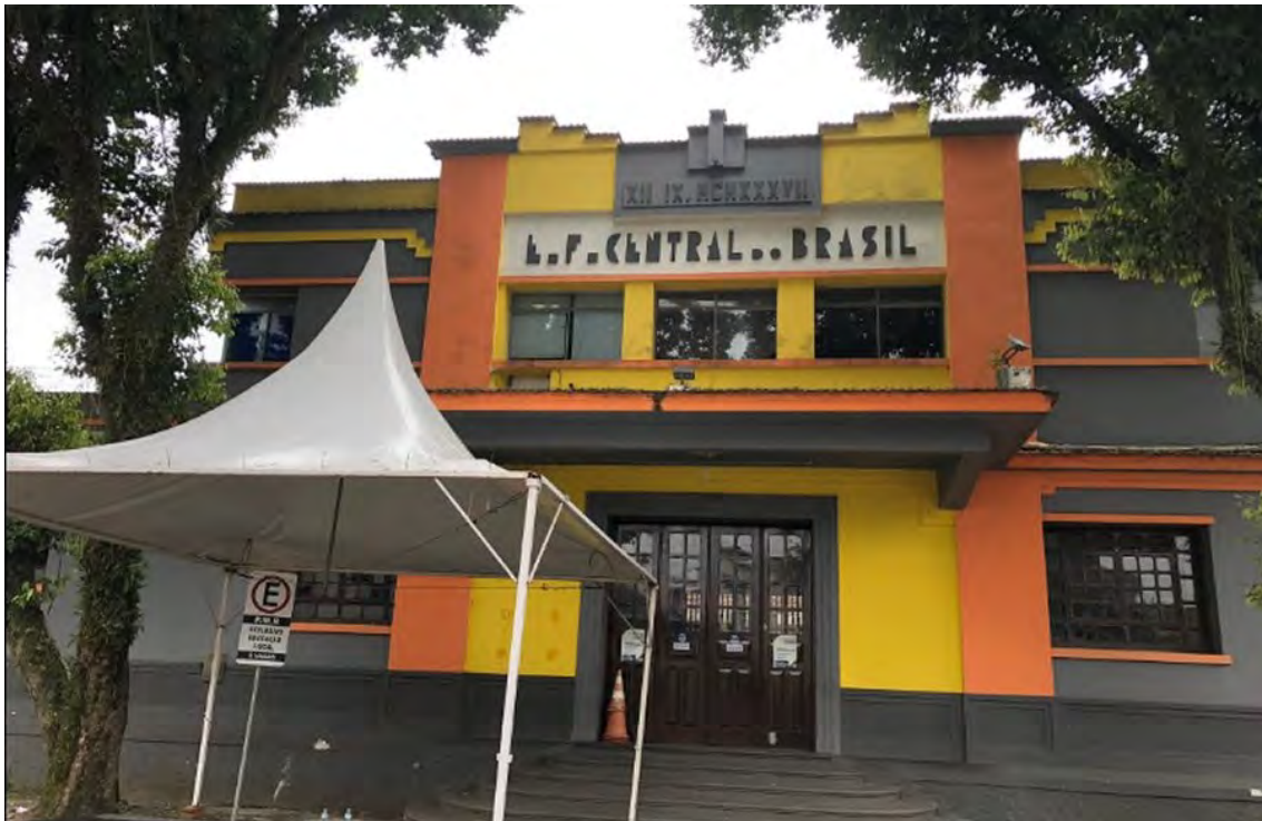
Figura 59 – Visão da entrada da Estação Agulhas Negras
