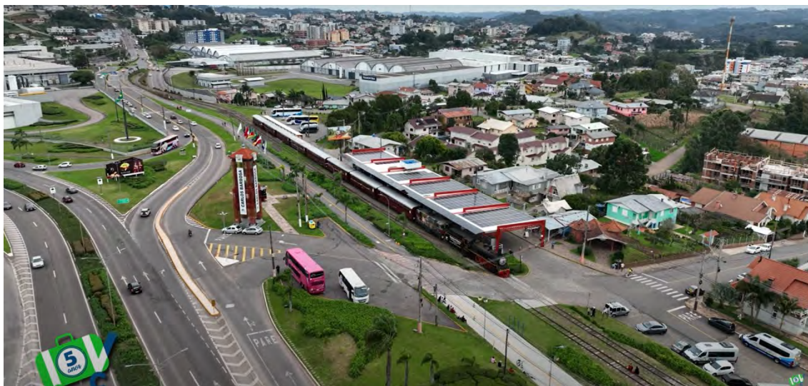
Figura 173 – Visão aérea da Estação Carlos Barbosa
