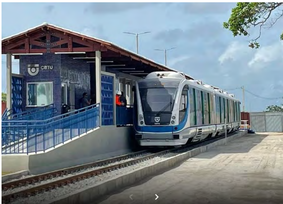
Figura 152 – Plataforma de embarque da Estação Cajupiranga
