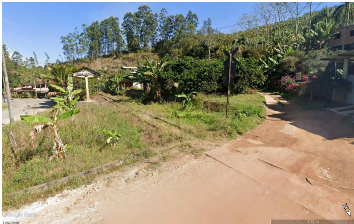
Figura 220 – Situação de segmento em Vargem Alta (ES) – 2021
