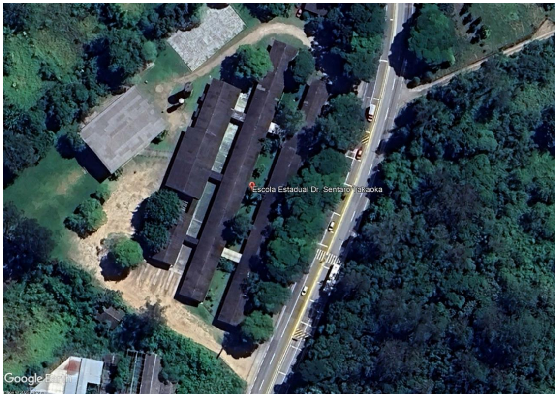
Figura 65 – Vista superior de escola em área rural, com elementos de moderação de tráfego (ondulação transversal e sonorizador) próximos à travessia de pedestres, além de radar fixo de fiscalização eletrônica de velocidade. Localizada na Rodovia SP-088, na cidade de Mogi das Cruzes (SP).
