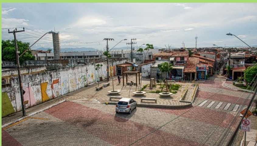
Figura 36 – Situação depois: ação permanente de intervenção no espaço.
