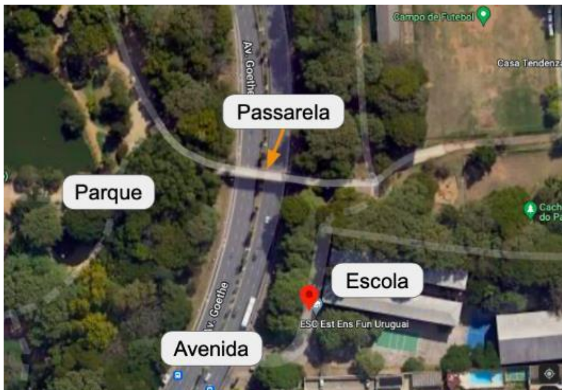
Figura 90 - Passarela de pedestres em contexto urbano, fazendo a conexão entre a escola e parque.
