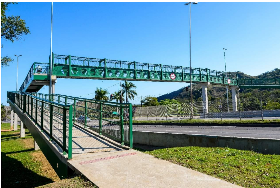
Figura 89 - Passarela para transposição de rodovia.
