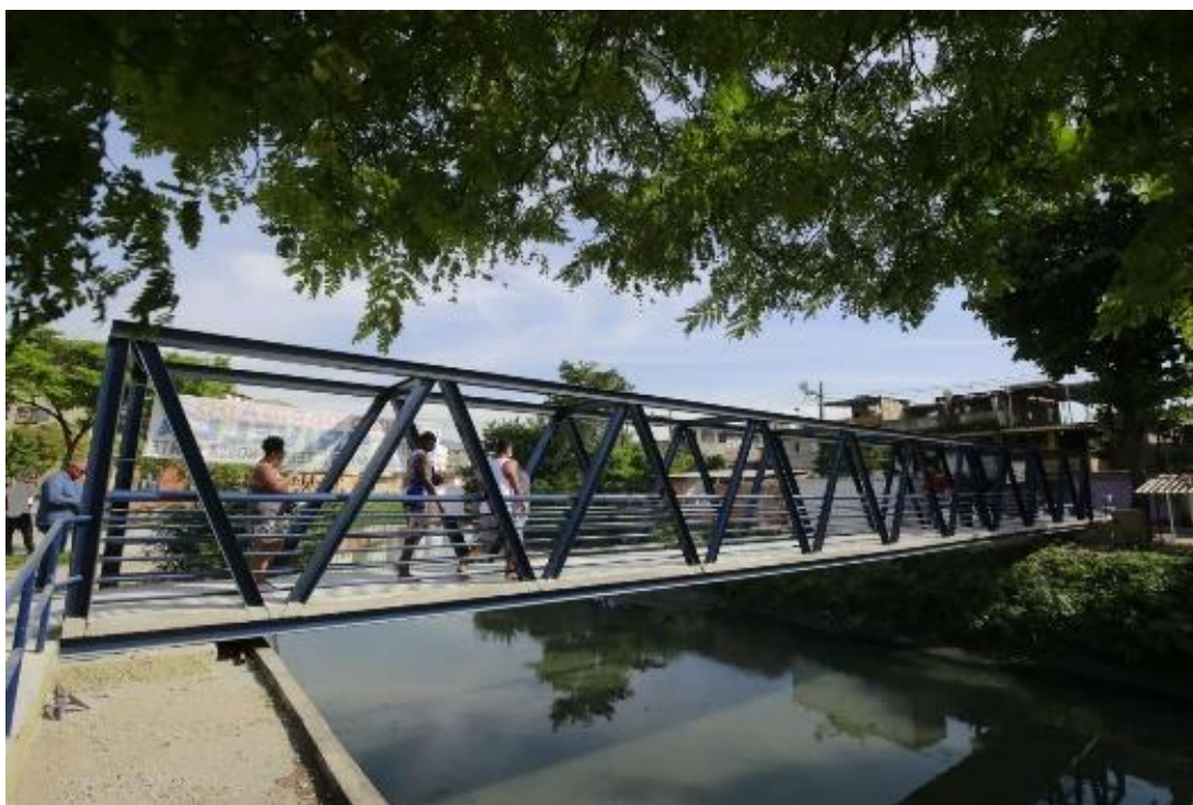
Figura 88 - Passarela urbana que permite transposição de um canal.
