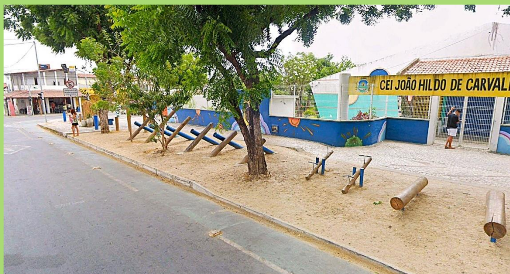
Figura 75 – Situação depois: antiga área de estacionamento transformada em um espaço de lazer e convivência.
