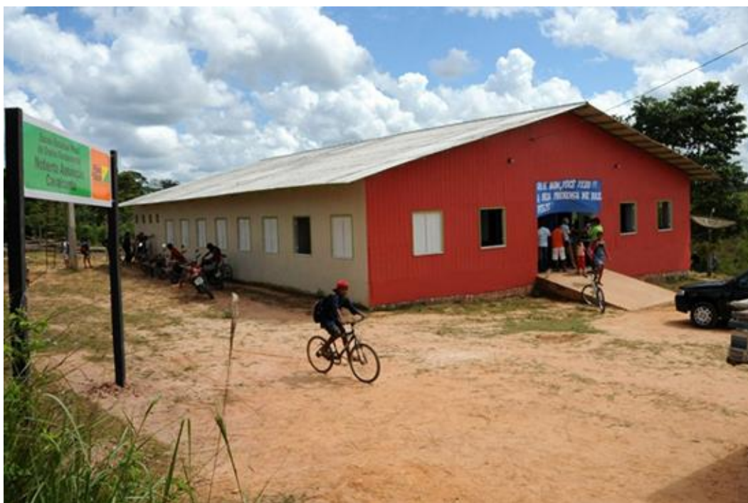
Figura 11 - Infraestrutura precária no entorno escolar.
