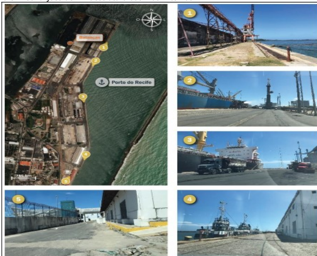
Figura 32: Condições de Infraestrutura das Vias Internas
