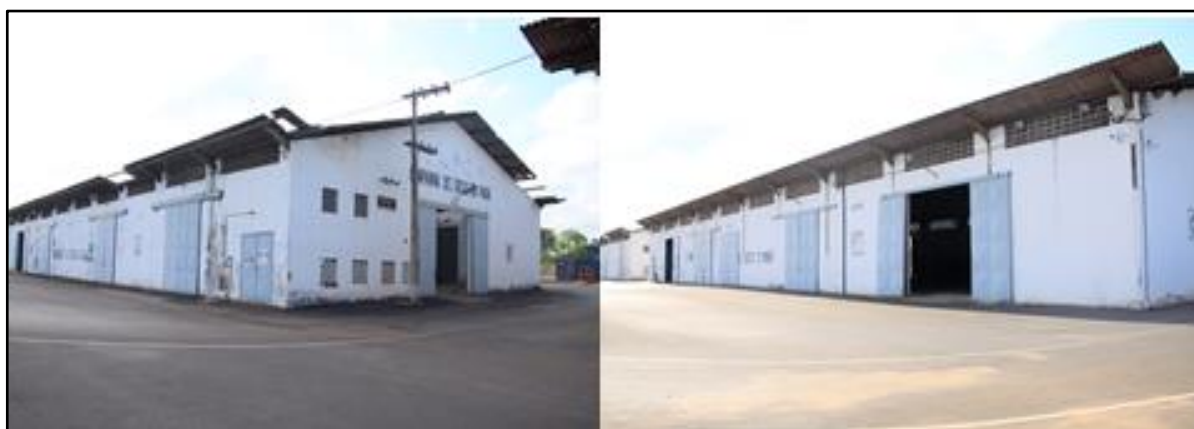
FIGURA 20 - GALPÕES PRÓXIMO AO PIER
