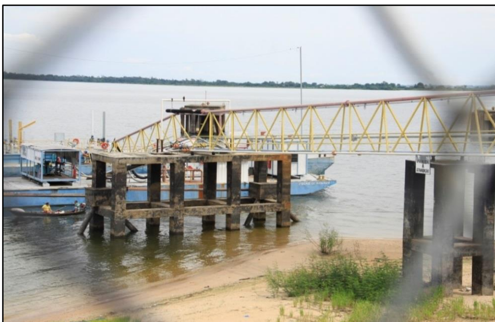
FIGURA 15 - TERMINAL DA FOGÁS - T01
