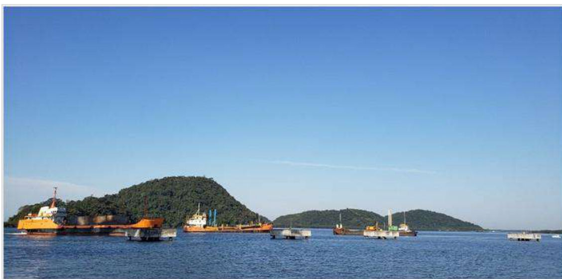
Figura 62 – Execução da dragagem na região dos dolfin (berço 219)
