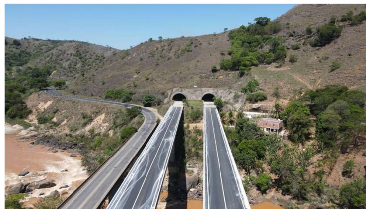
Túneis concluídos na BR-381/MG
