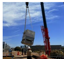
Troca das torres de resfriamento
