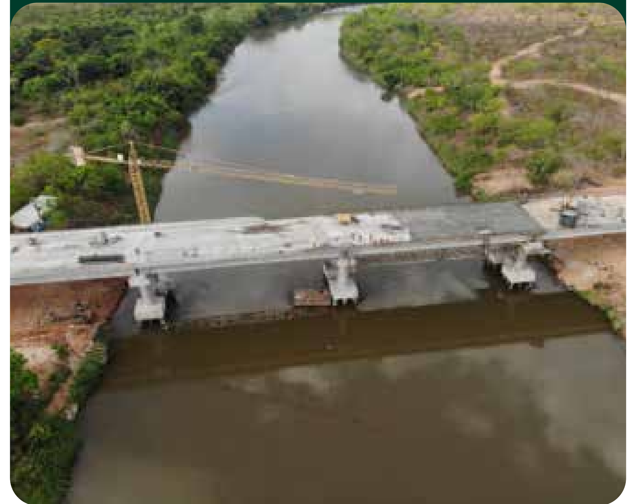
Ponte Ribeiro Gonçalves - Tasso Fragoso BR-330/PI/MA
