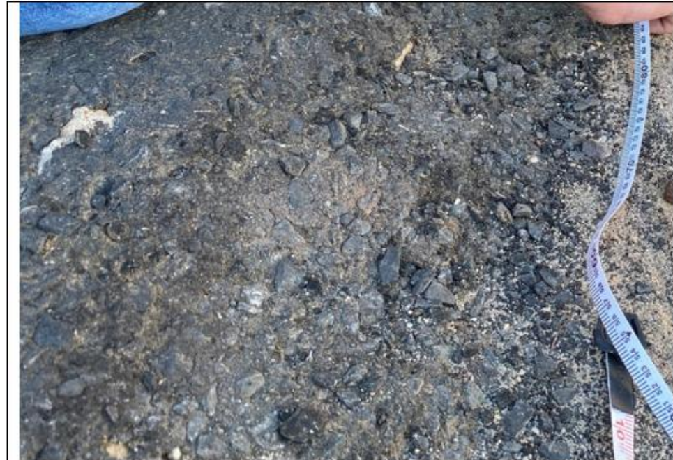
Figura 22: Foto indicando a presença de brita na massa asfáltica utilizada nas obras
