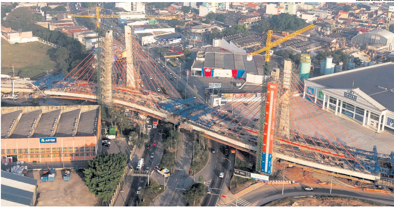
AVANÇO DA OBRA. Construção do viaduto estaiado se aproxima do término, trecho de 200 metros cúbicos foi concretado
