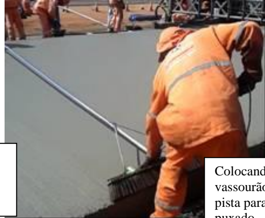
Corda que puxa o vassourão de um lado para outro da pista de concreto
