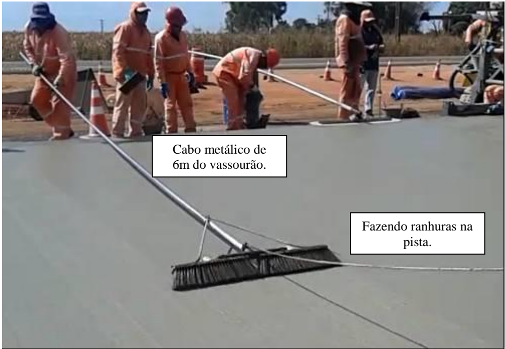
Corda que puxa o vassourão de um lado para outro da pista de concreto
