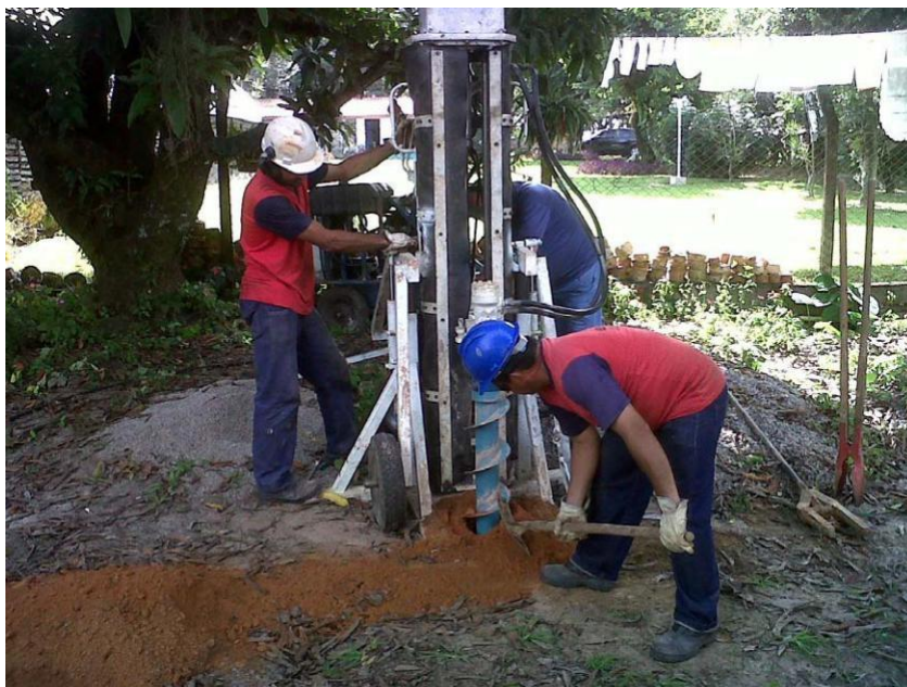
Figura 149: Execução de sondagem po hollow auger sem u lização de água
