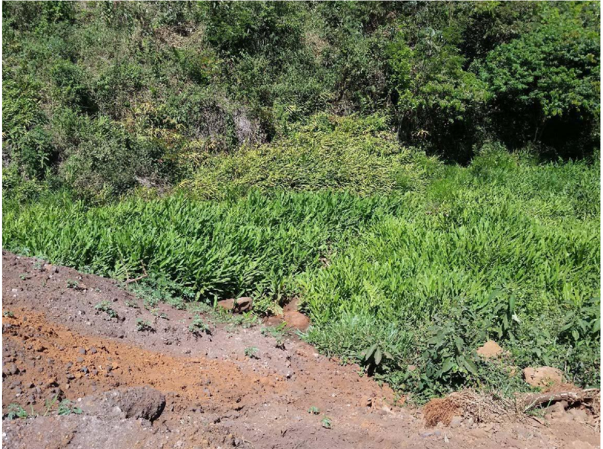
Figura 92: Vegetação alta no pé do talude
