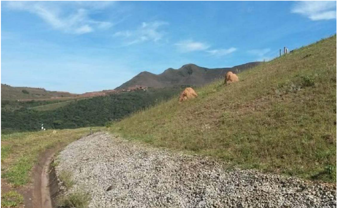
Figura 129: Formação de cupinzeiros no barramento
