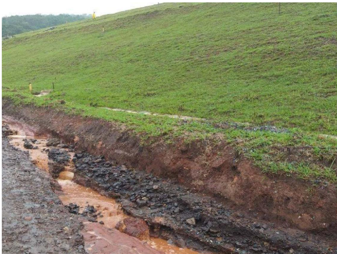
Figura 122: Erosão no pé da barragem devido a drenagem inadequada
