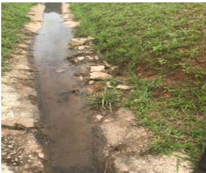
Figura 110: Canaleta de drenagem superficial parcialmente obstruída por lama
