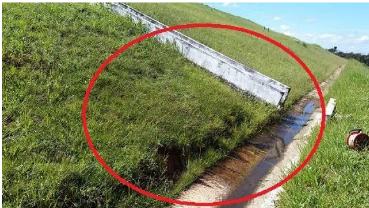
Figura 102: Surgência de água no talude próximo à canaleta de drenagem, que está assoreada
