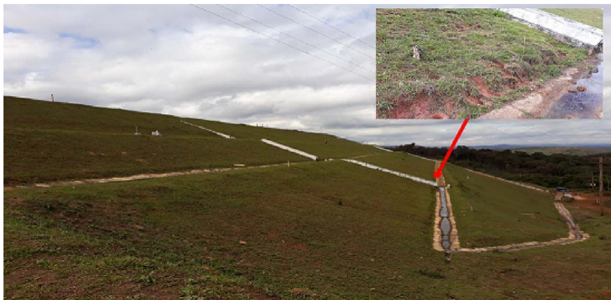
Figura 98: Surgência de água no talude junto à canaleta
