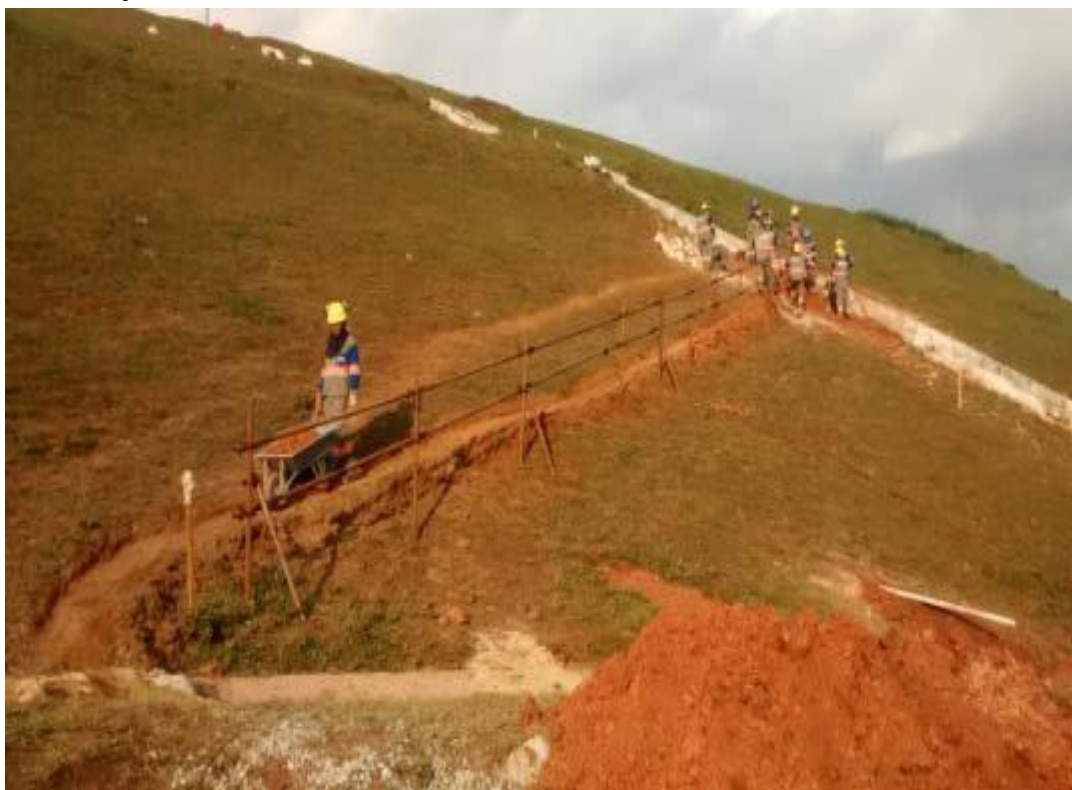
Figura 38: Serviço de regradagem de solo escavado do local onde ocorreu a fratura hidráulica
