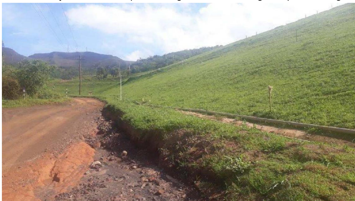
Figura 123: Formação de erosão no pé da barragem devido a drenagem superficial irregular
