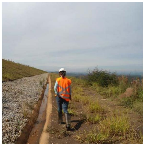
Figura 51: Empocamento em canaleta de drenagem superficial da B I
