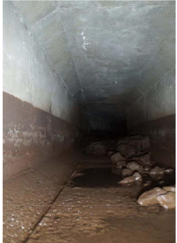
Figura 65: Vista da parte interna da galeria de fundo da B I, com acúmulo de rejeito mineral na parte inferior
