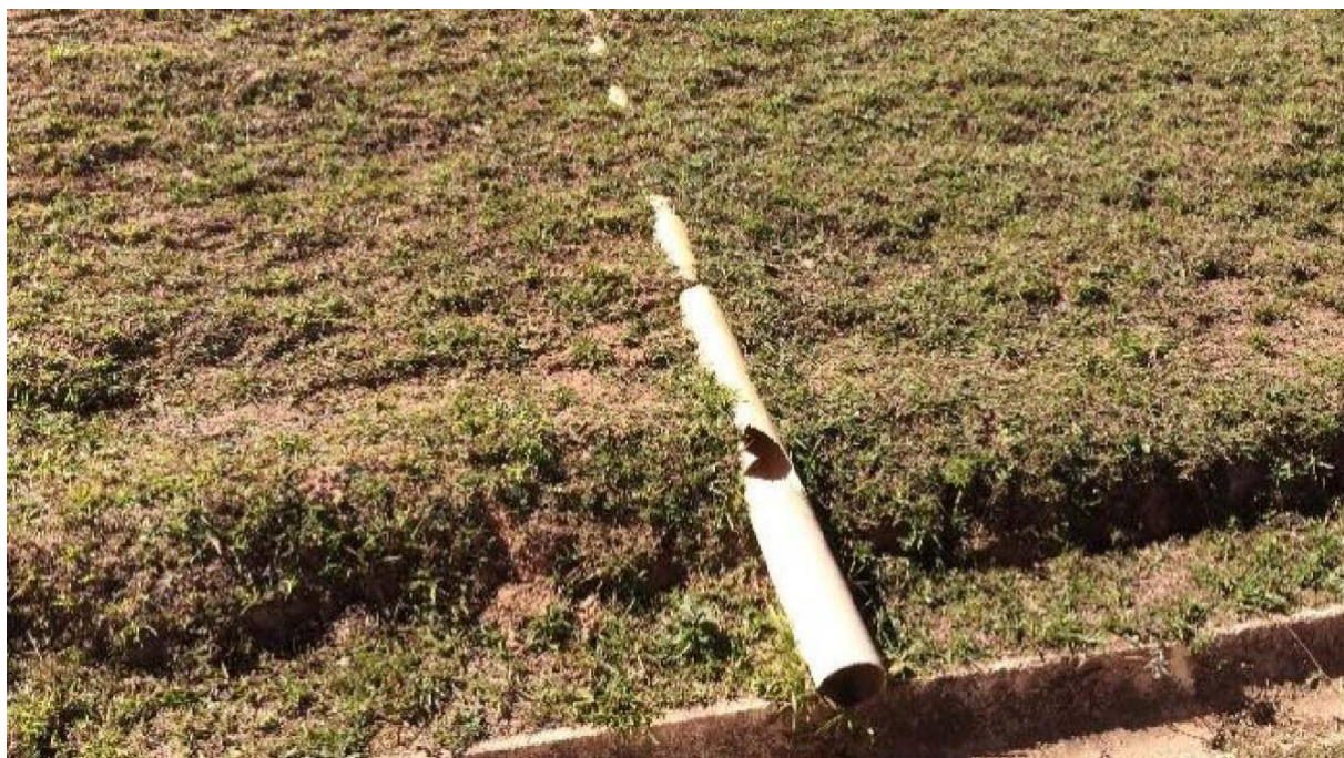
Figura 43: Tubo para saída de drenagem interna exposto e danificado na B I
