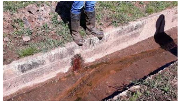
Figura 58: Surgência com colóide em canal de drenagem na B I
