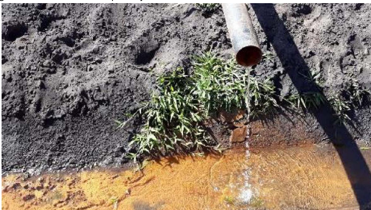
Figura 47: Saída de DHP com presença de colóide na B I
