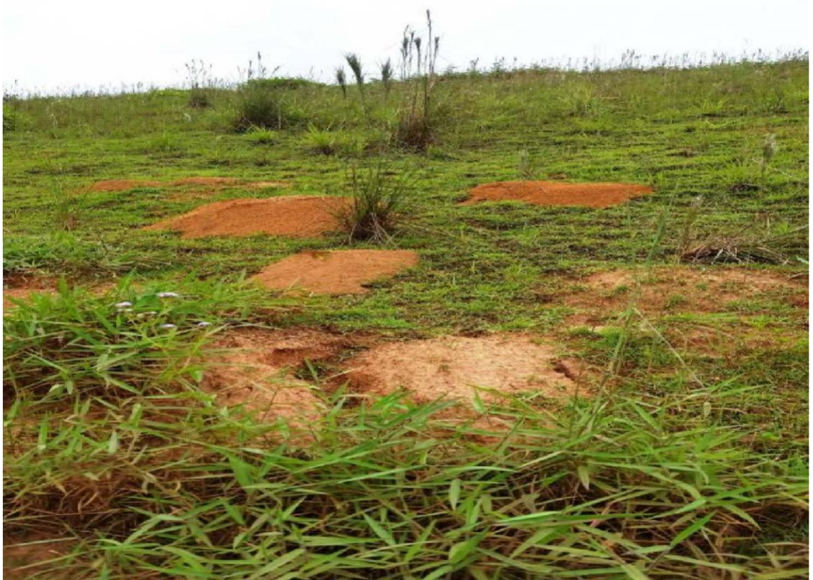
Figura 128: Formigueiros e cupinzeiros no barramento
