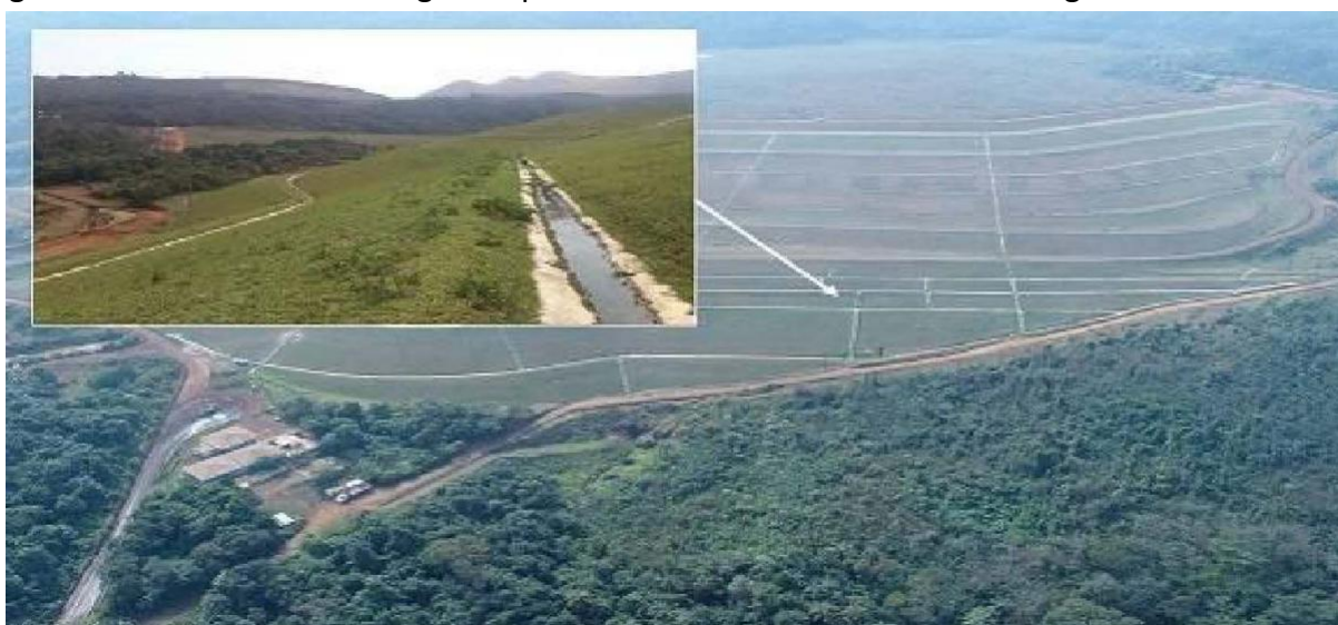
Figura 112: Canaleta de drenagem superficial assoreada com acúmulo de água
