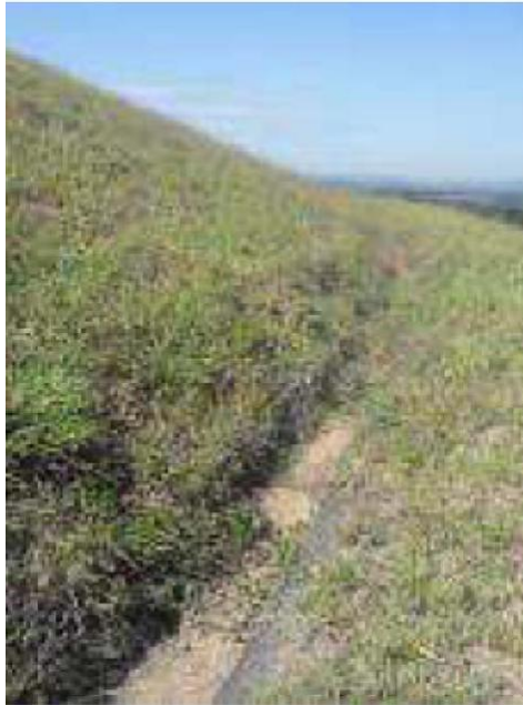
Figura 52: Trecho assoreado em canaleta de drenagem superficial acima da bermã de recuo na B I
