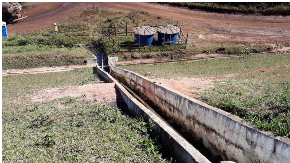
Figura 35: Canaleta em degrau onde ocorreu a surgência de água quando da perfuração de 15º DHP
