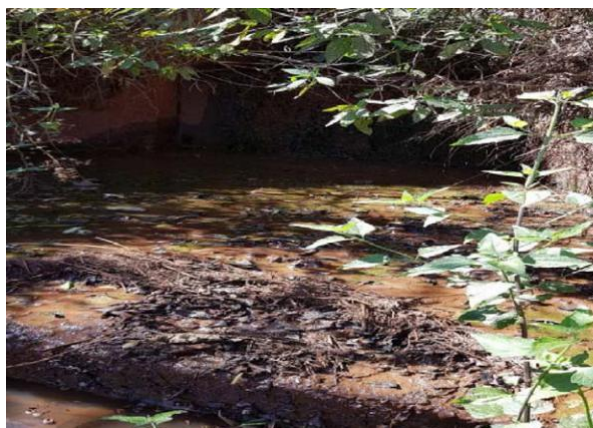
Figura 66: Detalhe da saída do extravasor da B I, assoreada e com erosão abaixo da laje a jusante
