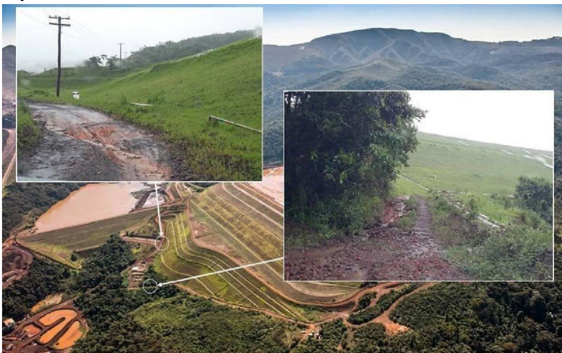
Figura 108: Drenagem superficial inadequada causando acúmulo de água no pé do barramento e formação de erosão
