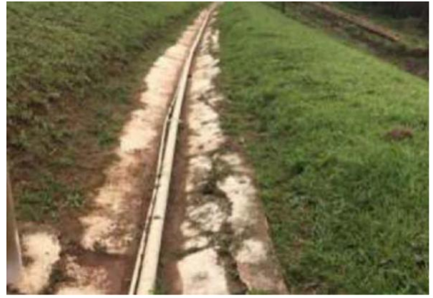
Figura 56: Canaleta de drenagem superficial na B I com danos no concreto
