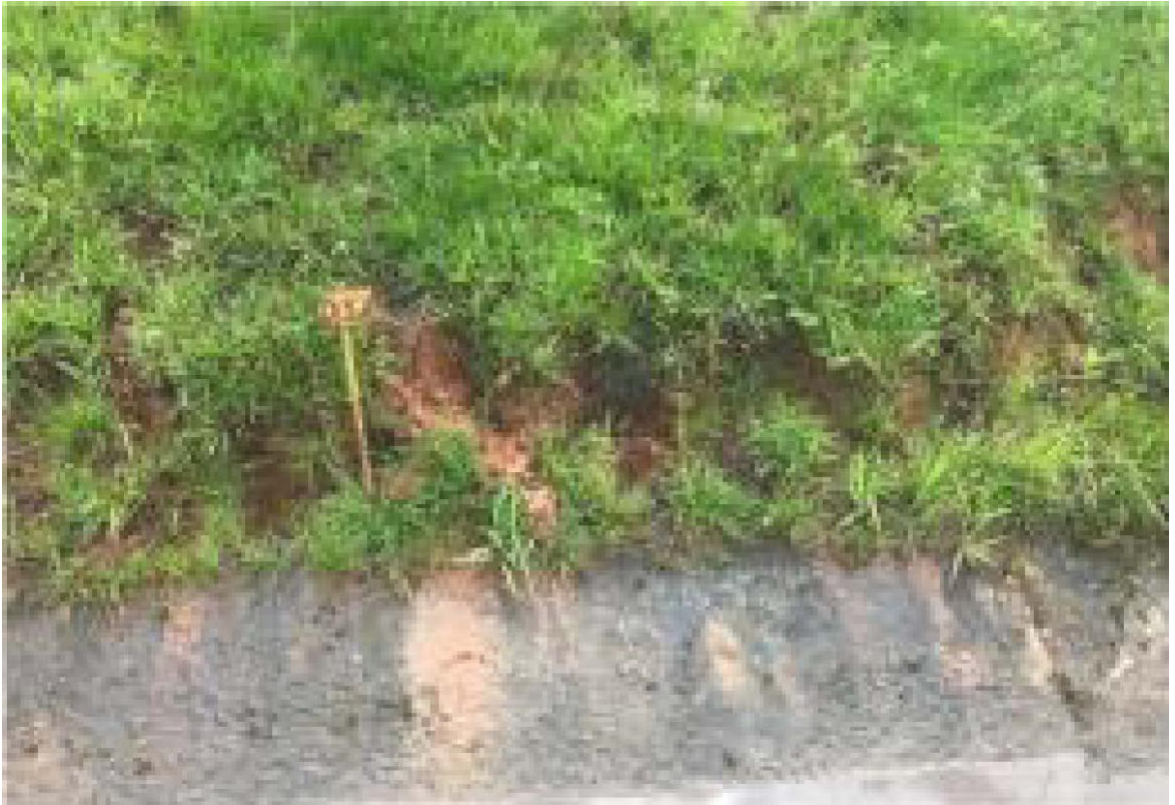
Figura 96: Surgência no talude principal com carreamento de material
