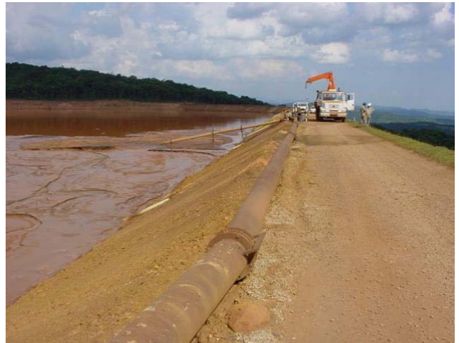
Figura 83: Barragem B I sem largura de praia em 2006
