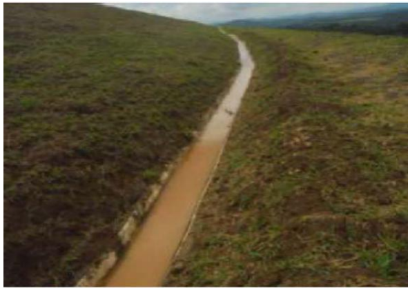
Figura 55: Canaleta de drenagem superficial na B I com empoçamento de água devido a deficiência na inclinação das mesmas
