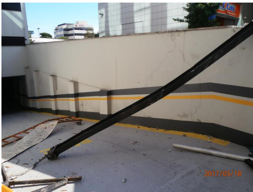
Viga leste e respectivo tripé catapultados sobre rampa da garagem:
