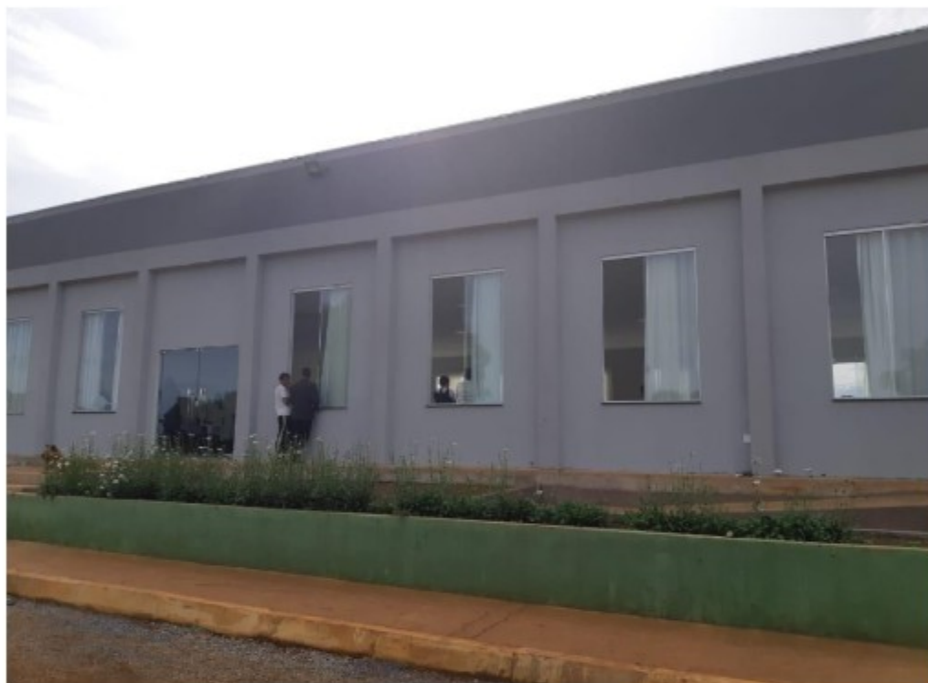
Foto 46 – Vista da área externa do templo da IARL.
