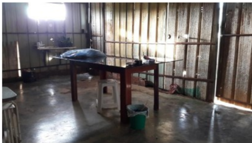
Foto 98 – Interior da oficina de costura. Destaque para a iluminação deficiente e o ofuscamento produzido pelas frestas na parede.
