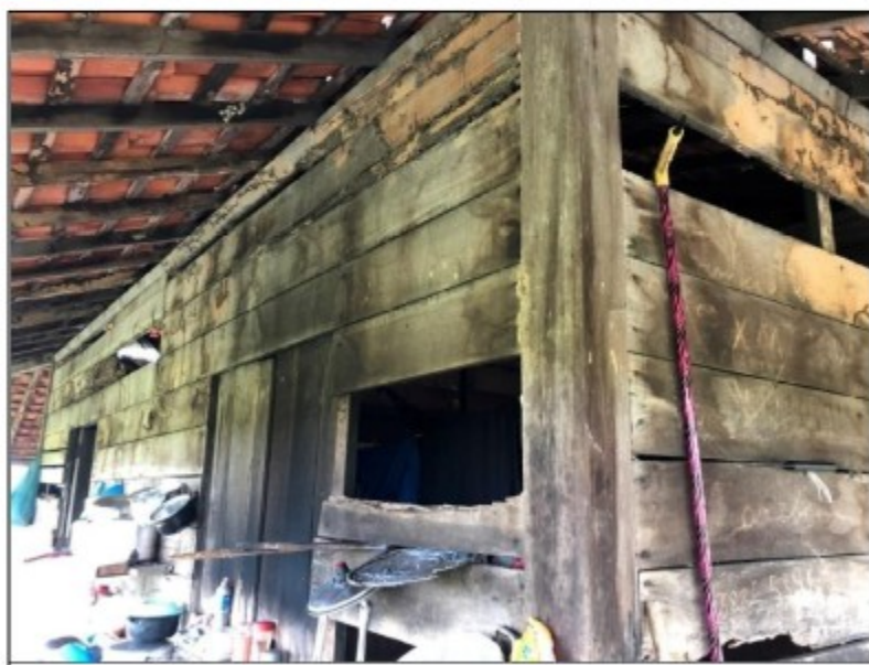
Fotos 5 e 6: vãos ou aberturas entre as tábuas que formavam as paredes do alojamento, fato que demonstrava falta de conservação e comprometia ainda mais o asseio e a higiene do barracão.
