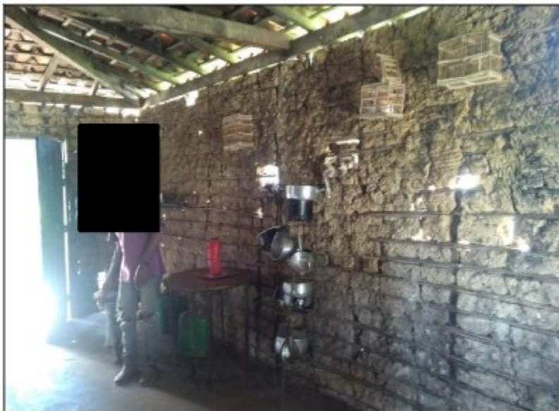
Fotos 7 e 8: paredes de barro, sustentadas por estacas de madeira, no barraco de taipa onde o trabalhador [REDACTED] residia.
