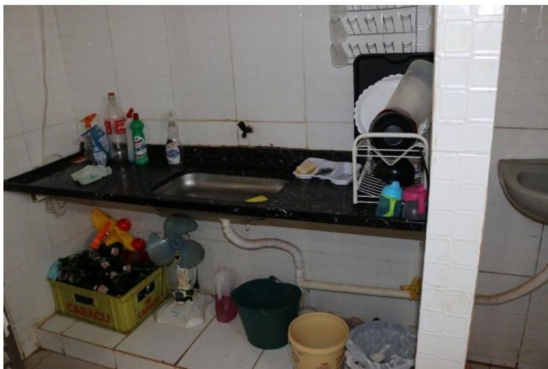
FOTO 11: Condições de higiene no interior da padaria.
