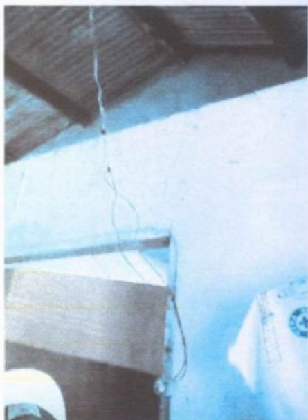
As instalações elétricas possuem uma série de emendas improvisadas, sem o devido isolamento. Foto do alojamento do [REDACTED]
