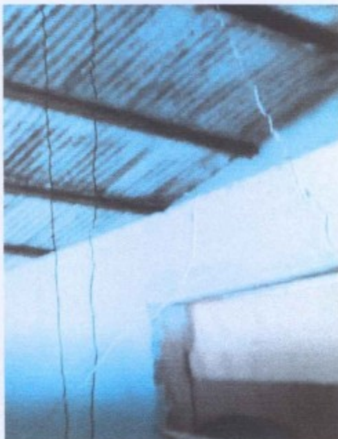
As instalações elétricas possuem uma série de emendas improvisadas sem o devido isolamento. Foto do alojamento de [REDACTED]
