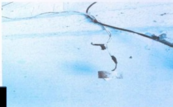
As instalações elétricas do alojamento de [REDACTED] eram péssimas, com fios soltos e isolamentos improvisados, o que gera risco de choque elétrico e incêndio.
