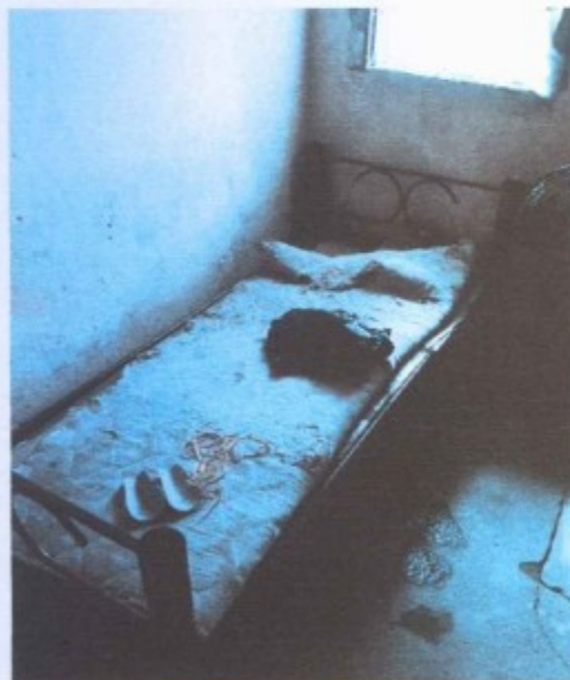
Condições de uma das camas do alojamento, e não há janela no cômodo. Para proteger, o [REDACTED] colocou um tecido, para interromper os ventos ou a chuva.
