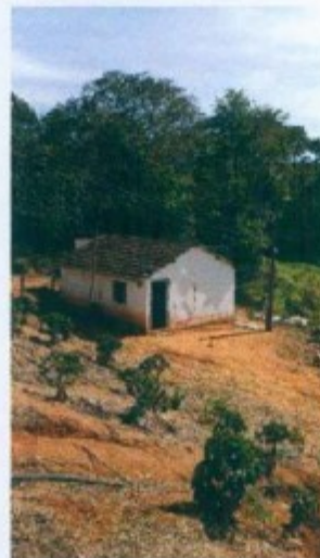
Vista geral do alojamento 2
