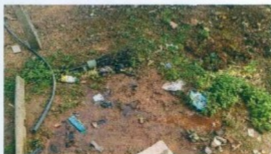
Lixo jogado ao redor da edificação
