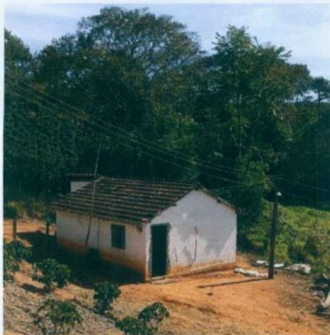
Visão externa - Alojamento II
