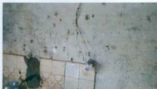
Detalhe fiação elétrica
