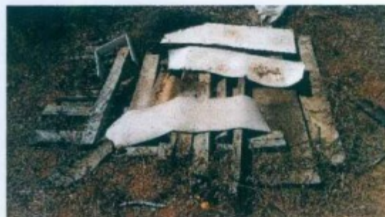
Buraco do esgoto
