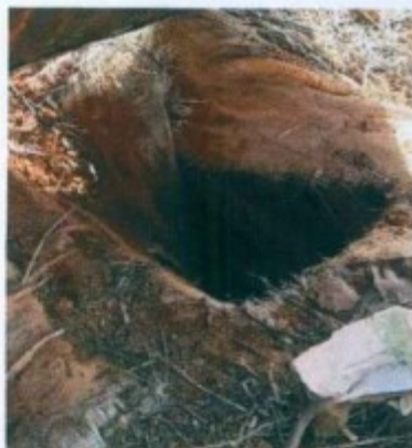
Buraco onde se joga o esgoto
