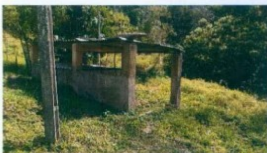
Distribuição da água que vem da nascente
