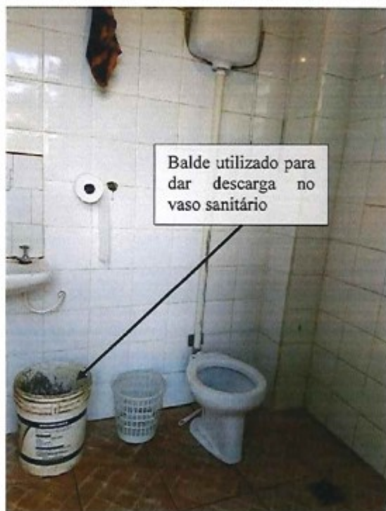
Im. 21. Vista das instalações sanitárias do alojamento da Faz. Cedro II. Registro efetuado em 18/07/2018.
