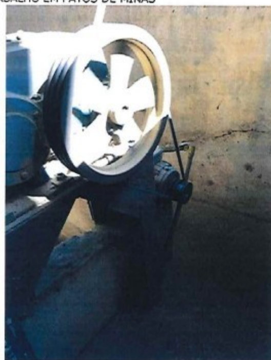
Im. 29. Maquinário na Faz. Congonhas com transmissões de força sem proteção. Registro efetuado em 19/07/2018.
