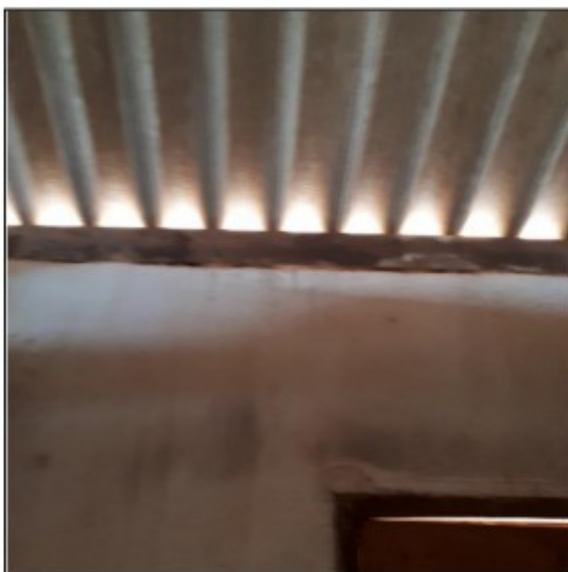
Fotos: Aberturas inadequadas nas paredes do depósito de agrotóxicos. Galinha encon
