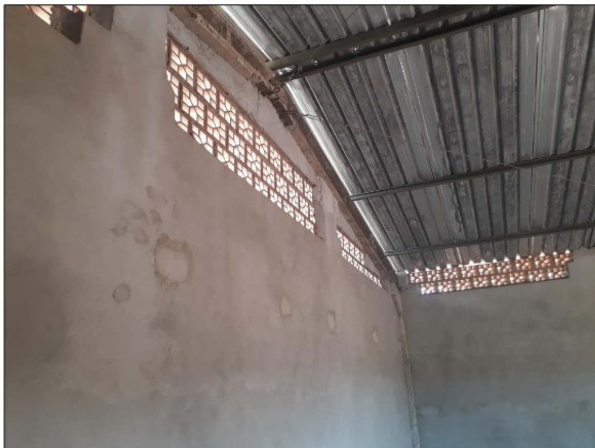
Foto: Elementos vazados de cerâmica na parte lateral superior do depósito.
