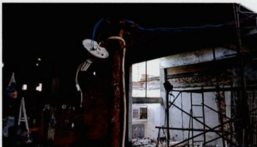
Figura 20: Instalação elétrica com risco de choque
