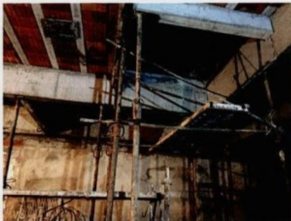
Figura 16 e 17 Abertura de piso sem proteção contra quedas.
