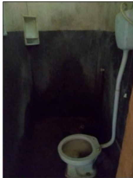
Foto 2: Instalação sanitária destinada aos trabalhadores.
