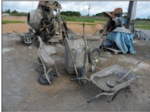
Foto 6: Betoneiras encontradas no local.
