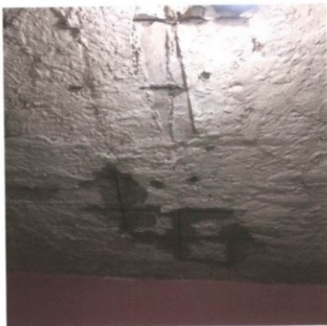
Mofo e infiltrações na laje do banheiro.
