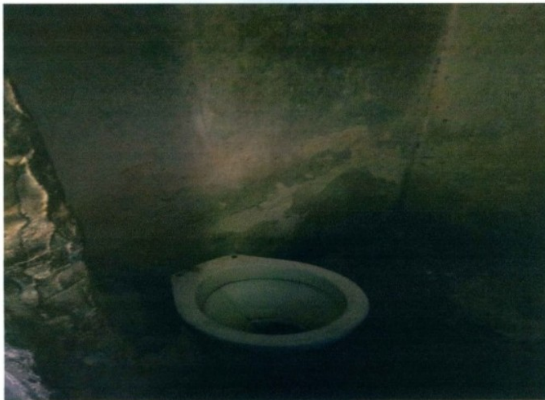
Fotografia das instalações sanitárias utilizadas pelo trabalhador resgatado e seu filho. O local não possuía descarga ou chuveiro. As paredes estavam extremamente envelhecidas, infiltradas e mofadas. O local também não possuía porta e o piso estava bem desgastado e rachado.
