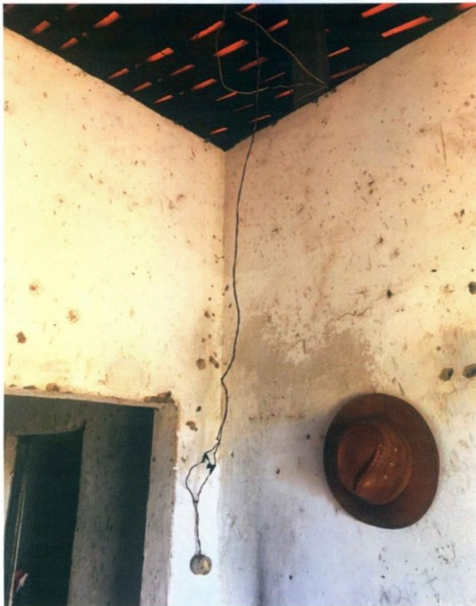
Fotografia das péssimas condições das instalações elétricas do alojamento. A fiação estava não enclausurada, envelhecida e com o isolamento elétrico soltando.
