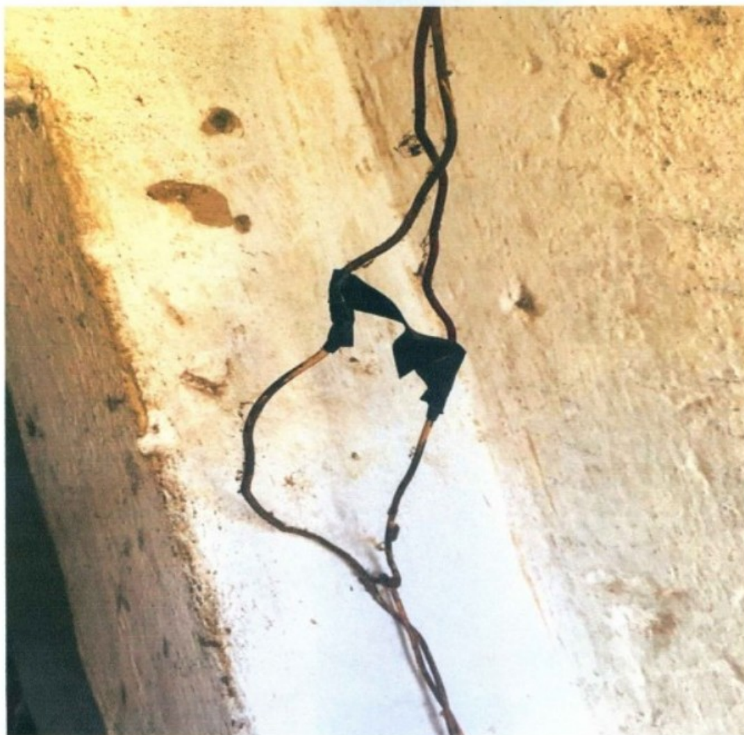
Fotografia das péssimas condições das instalações elétricas do alojamento. A fiação estava não enclausurada, envelhecida e com o isolamento elétrico soltando.
