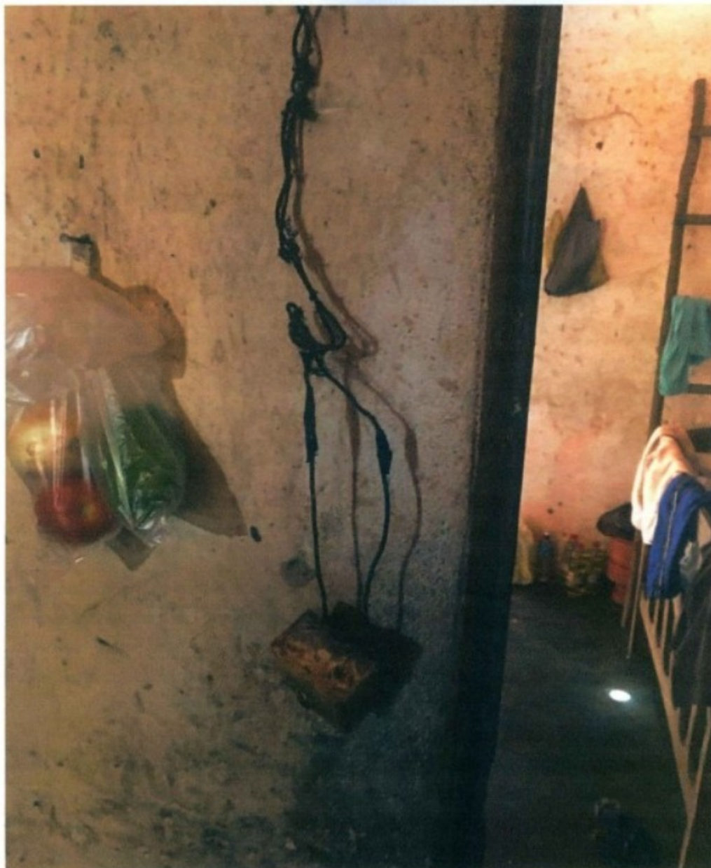
Fotografia das péssimas condições das instalações elétricas do interruptor da cozinha do alojamento, sob um novo ângulo.
