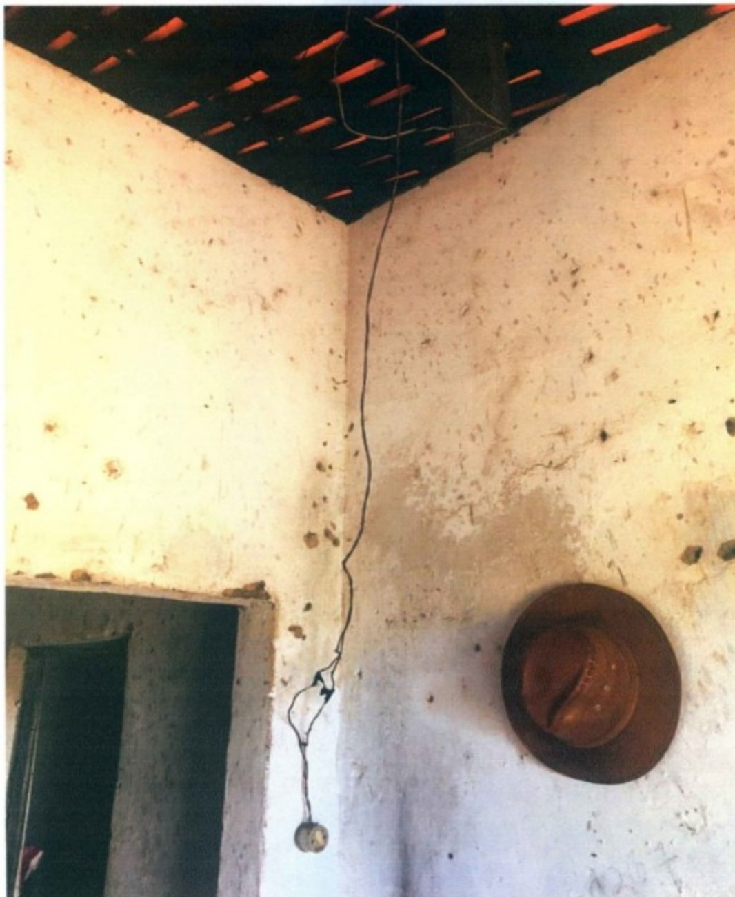
Fotografia das péssimas condições das instalações elétricas do alojamento. A fiação estava não enclausurada, envelhecida e com o isolamento elétrico soltando.
