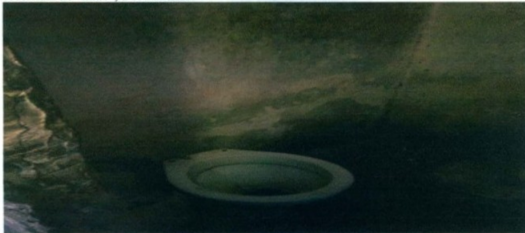
Fotografia das instalações sanitárias utilizadas pelo trabalhador resgatado e seu filho. O local não possuía descarga ou chuveiro. As paredes estavam extremamente envelhecidas, infiltradas e mofadas. O local também não possuía porta e o piso estava bem desgastado e rachado.
