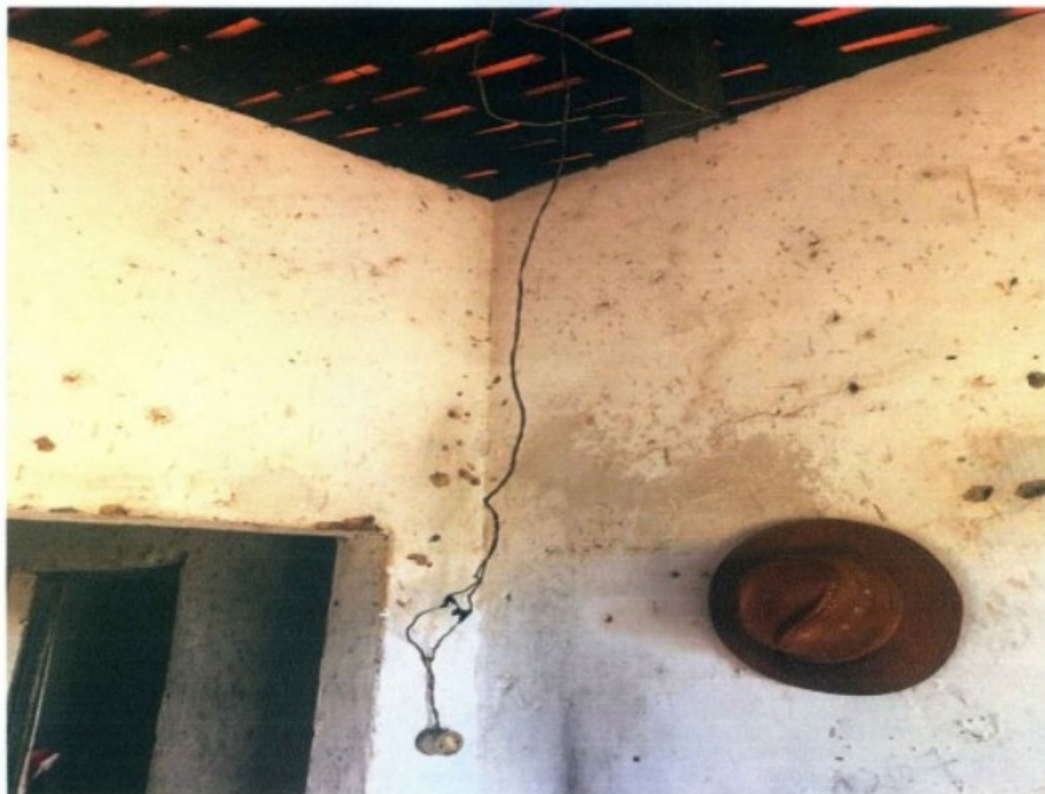
Fotografia do estado de conservação e higiene das paredes do alojamento. As paredes estavam completamente deterioradas, com fragmentos de pintura e rebocos também soltos. Elas estavam manchadas em quase toda sua extensão de fezes de animais, provavelmente ratos e morcegos
