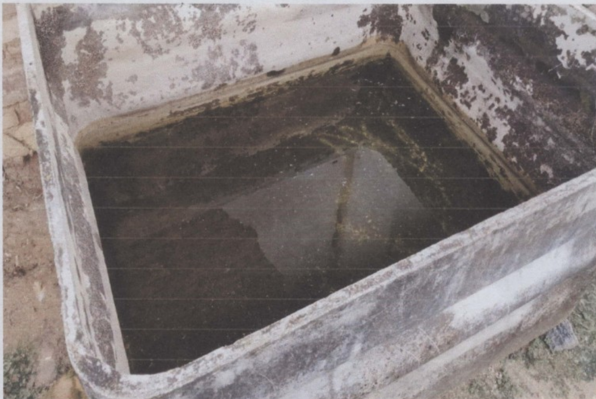
Tanque de amianto em que a água era armazenada
