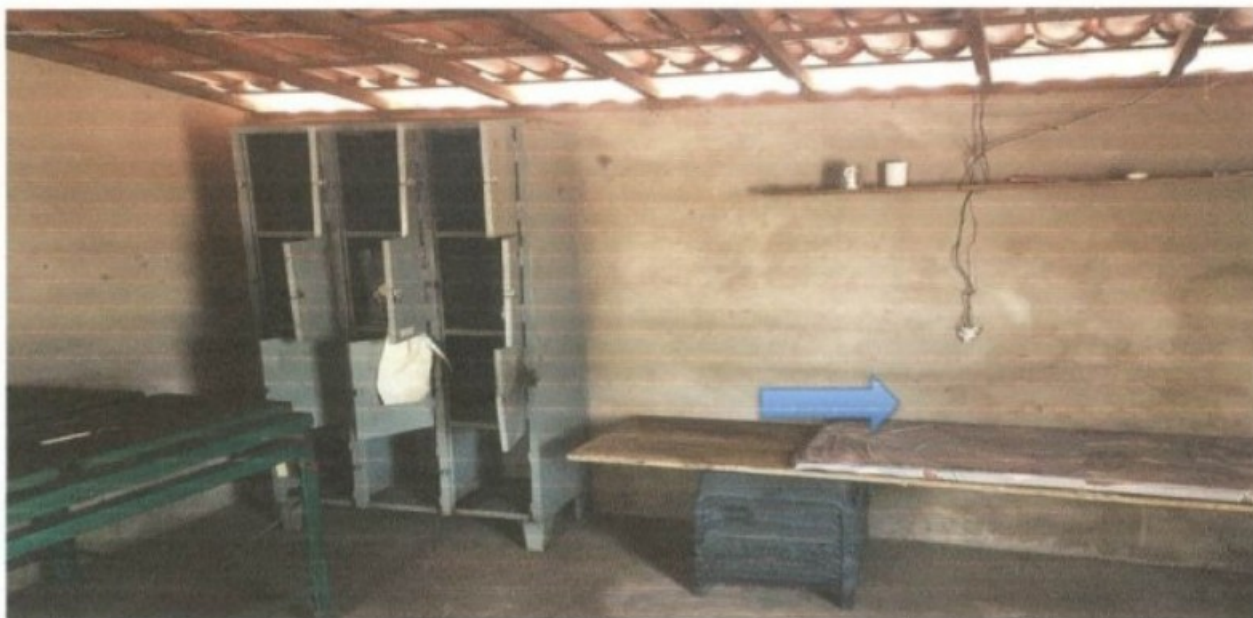
Instalação elétrica do alojamento improvisada, com o uso de disjuntor como interruptor para acender a luz.
