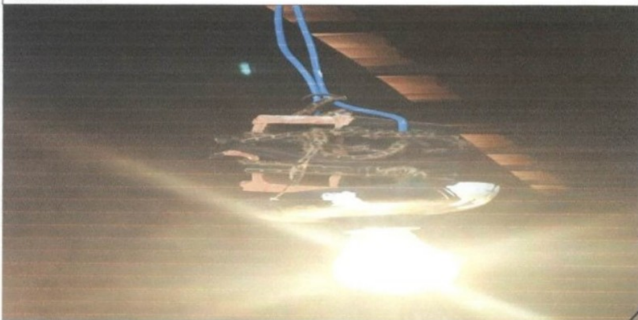
Instalação elétrica improvisada e com risco de choque elétrico, a qual está instalada no local de preparo das refeições (oficina próximo ao alojamento de [REDACTED]). A lâmpada foi ligada de forma improvisada, inclusive com um improviso no uso de bloco cerâmico para estabilizá-la.
